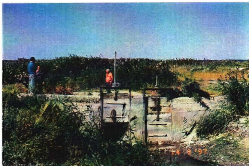
二次水路状況（ゲート右側が壊れている）
