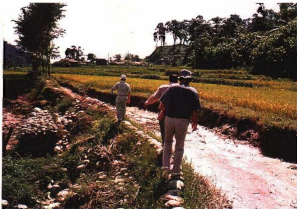
堆砂や崩壊により十分に機能をしていない用水路
