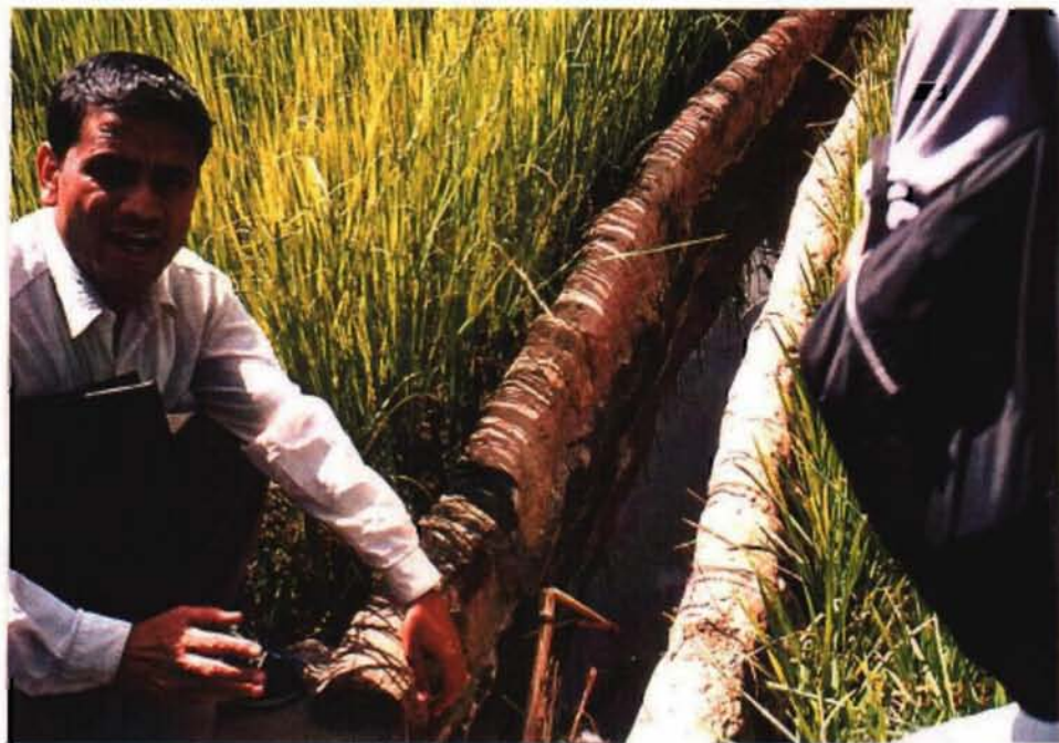
SPINプロジェクトサイトでの支線水路 (セメントは国が支給し、施工は農民が行っている)
