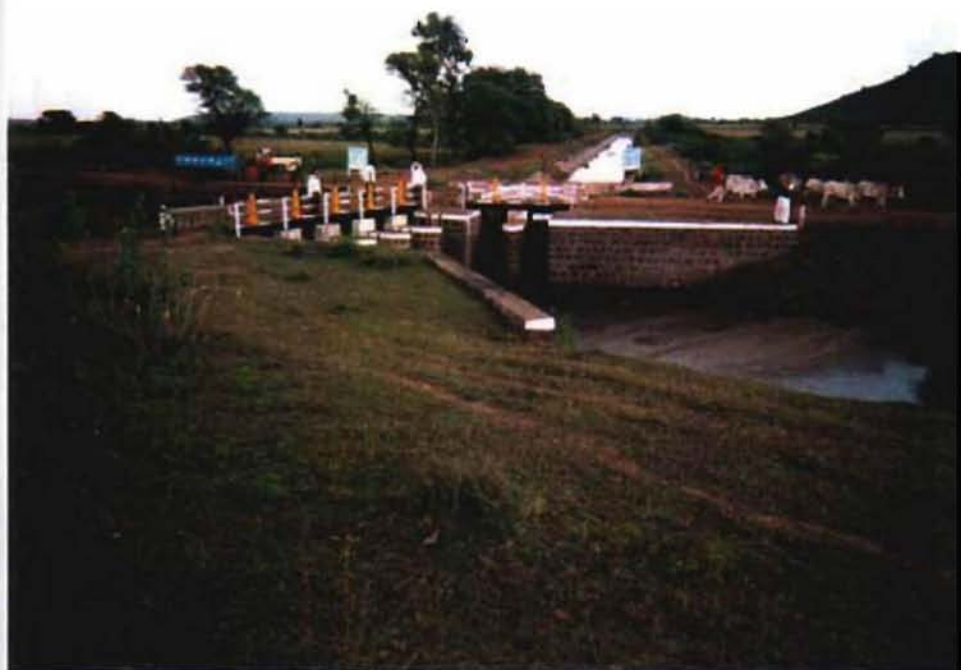
⑪ ハラリ地区左岸幹線と右岸幹線の分岐点
