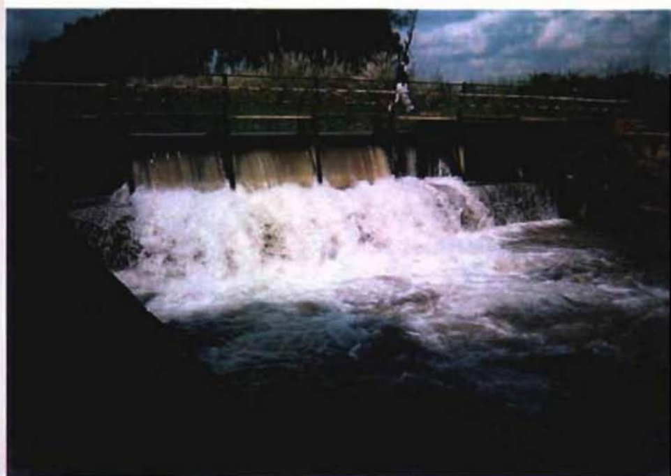
⑦ 上ガンガ地区落差工 (平坦地ファームpond設置候補地の一例)
