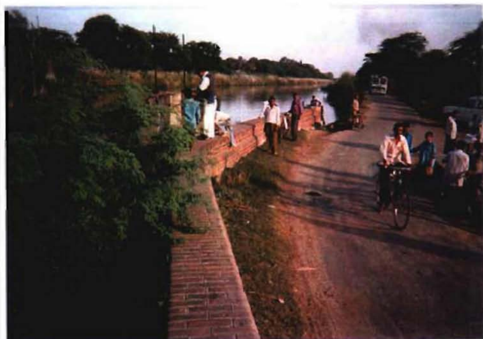
④ 上ガンガ幹線水路から1次支線への分岐点
