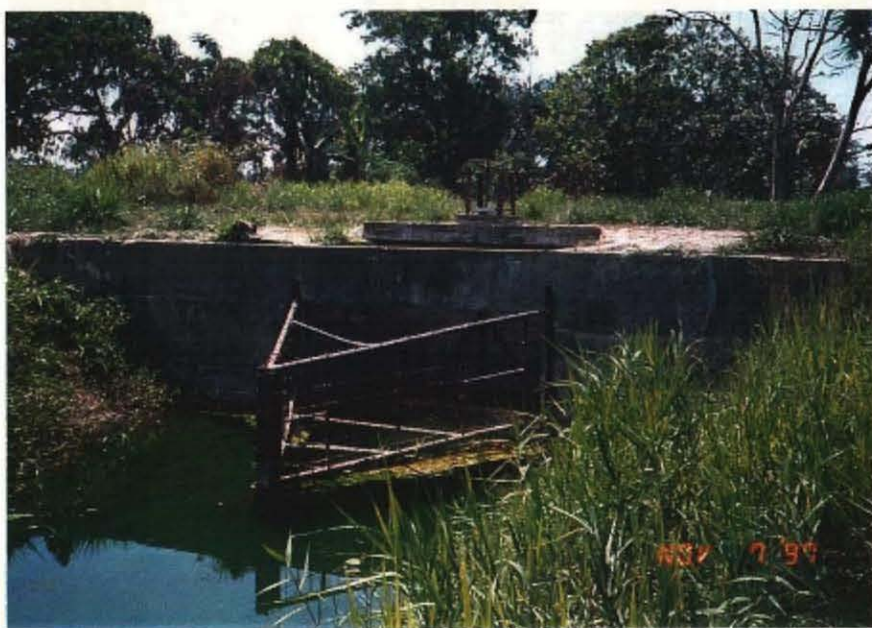
← メタボナ幹線水路始点 ソロモン政府農業部の 施工による
