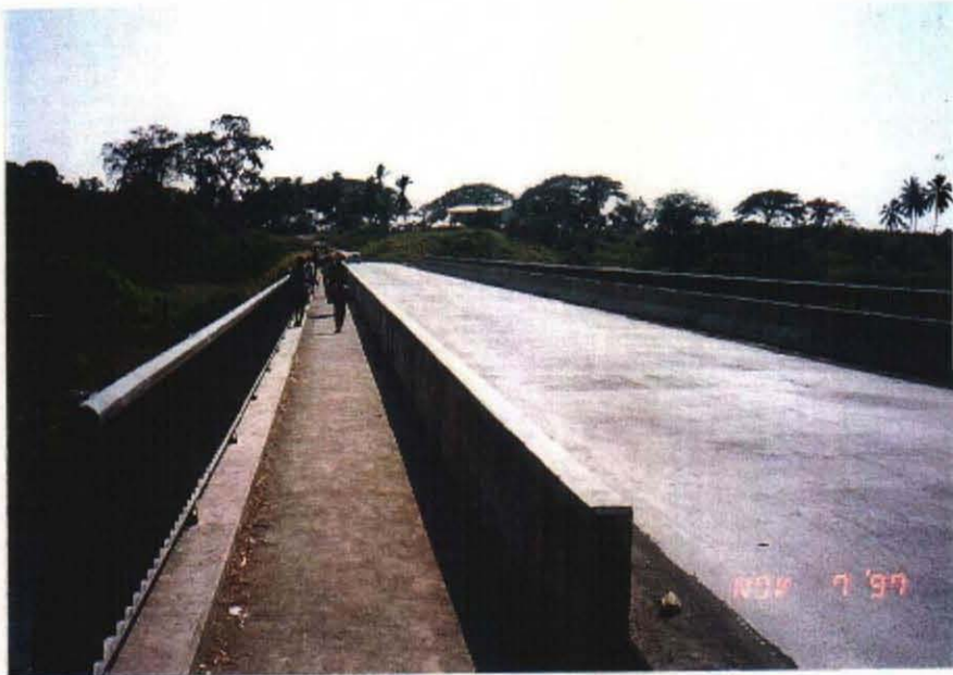
← ルンガ川橋梁 日本の無償協力による建設 左岸直下流が流量観測所
