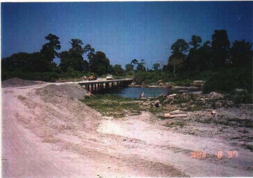
← ボコキンボ川橋梁 日本の無償協力による建設 Submersible Bridge
