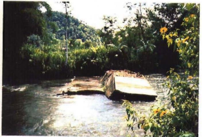
洪水流によって破損した取水堰 同
