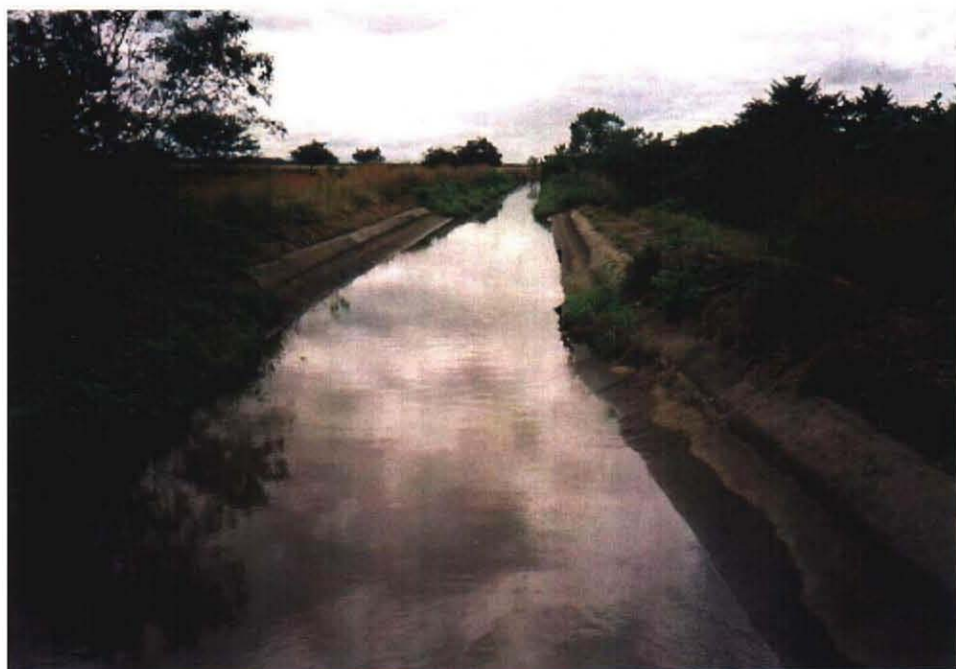
ビエッホ川左岸側の幹線用水路
