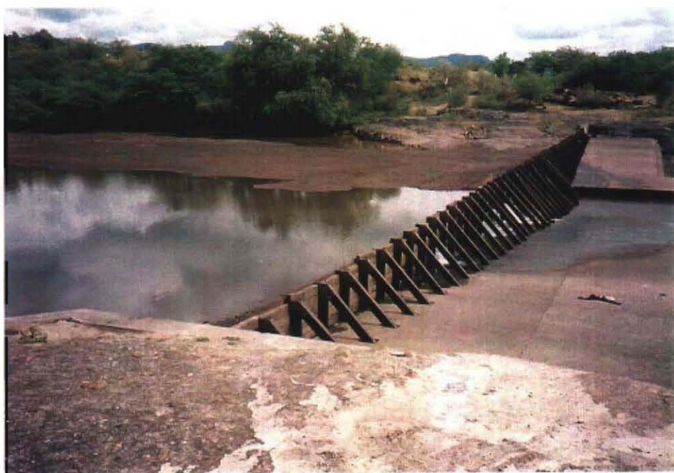
同上頭首工の堰本体(上流側より望む)
