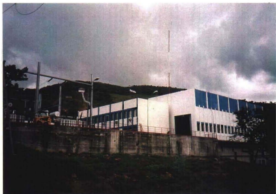
同上ダムより導水された水力発電所
