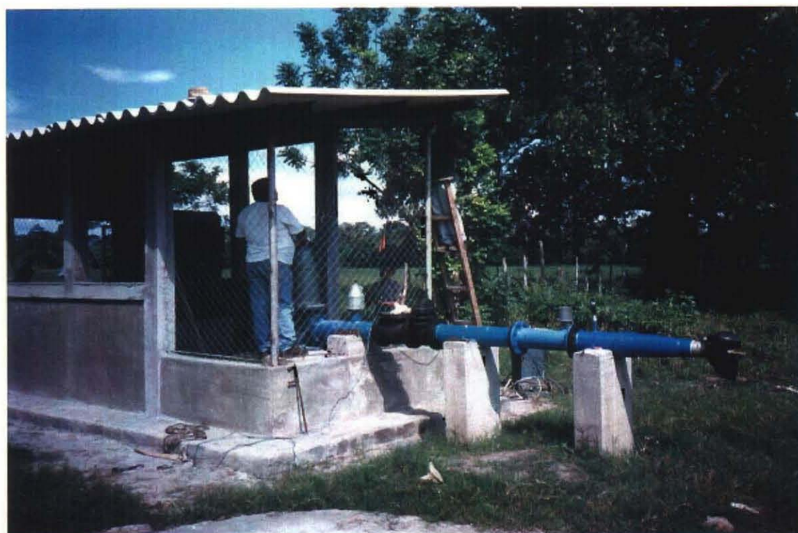
地区内に新設された灌漑用ポンプ設備
