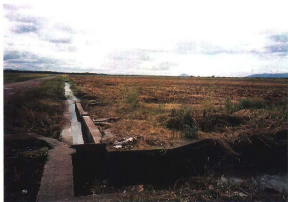
ビエッホ川左岸側の整備された二次水路網と水田
