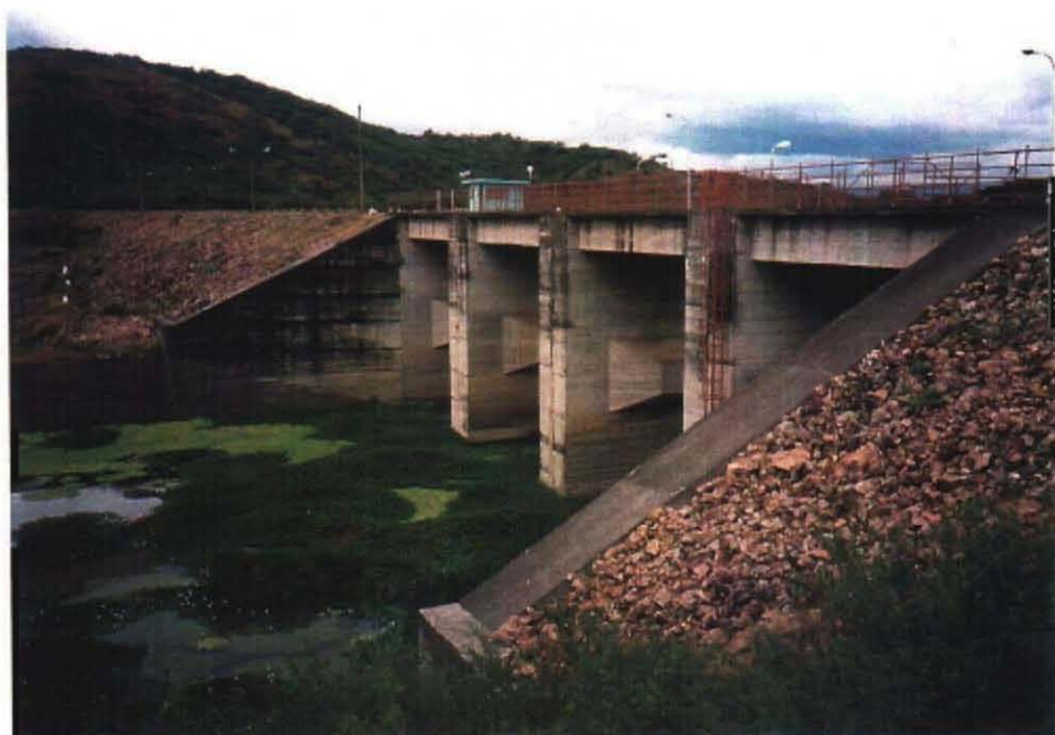
ビエッホ川上流にあるサンタ・バルバラダム
