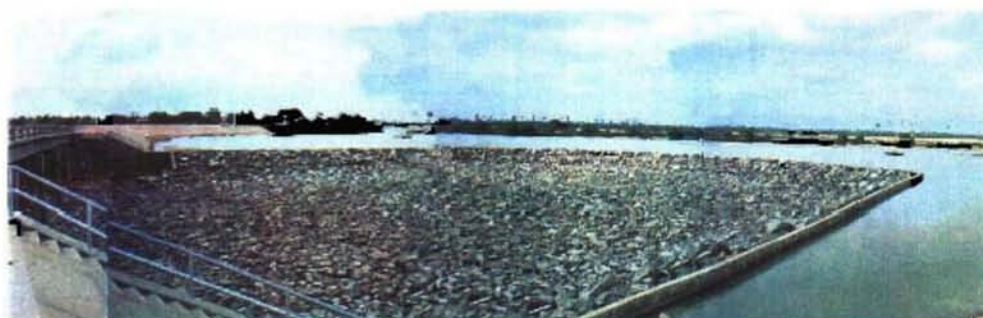
Kompong Tuol Spillway (Morning Glory Type)
