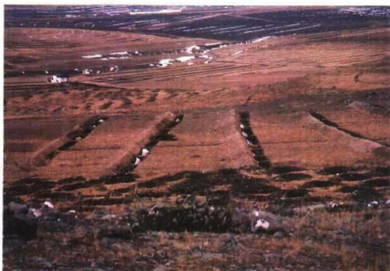
傾斜地の階段畑と地表水流出防止工（水平溝）の組み合わせ
