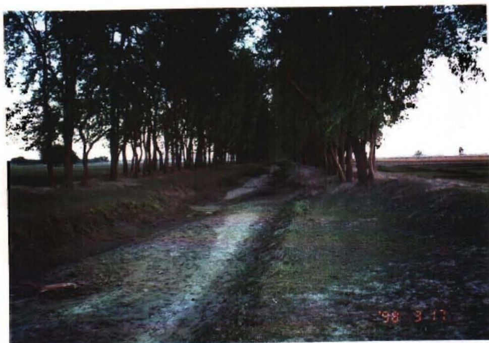
スンサリ・モランかんがい事業の第1支線水路、中流以下に用水が到達せず、堆砂に埋っている。
