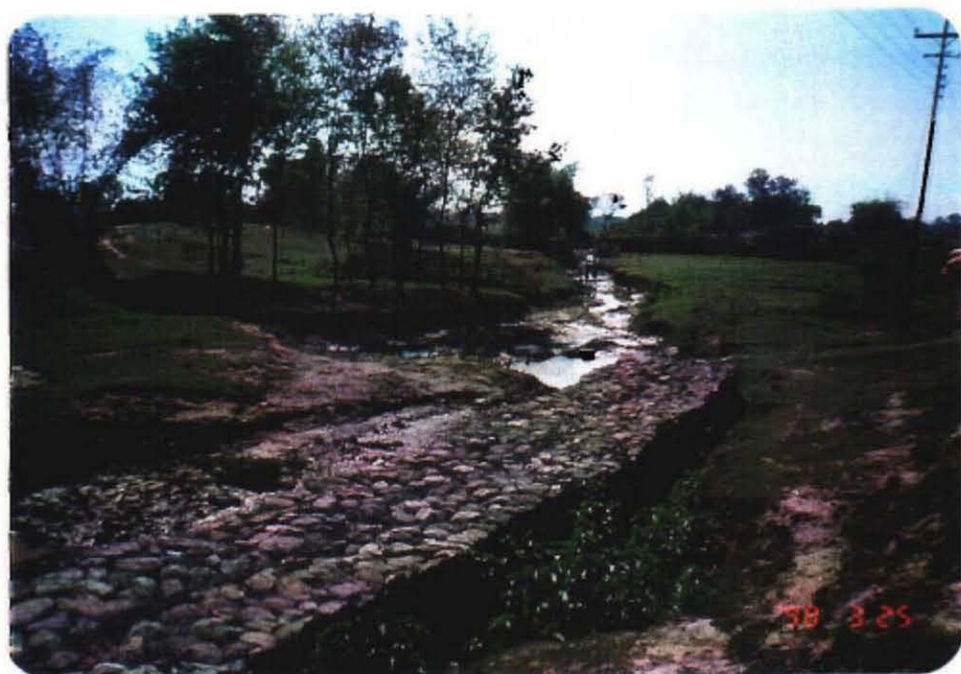
ダンデウクリ郡のラブティ川から取水される国道 沿線の水路と法面崩壊防止のための護岸工。
