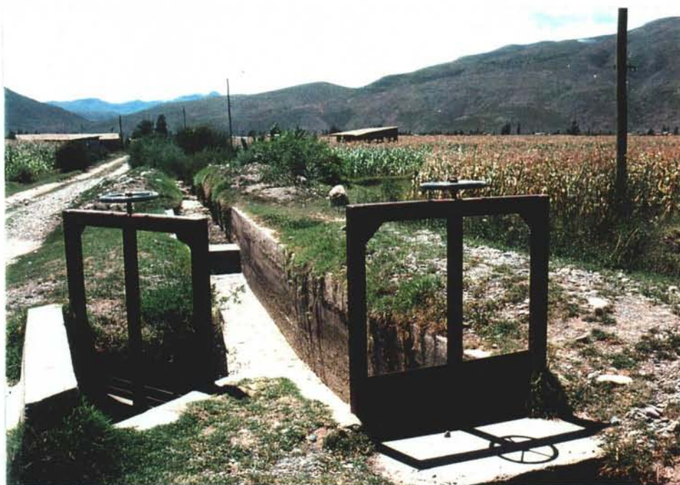
調査地区内のかんがい設備、幹線水路はコンクリートライニング水路だが、水源不足のため使用されていない。
