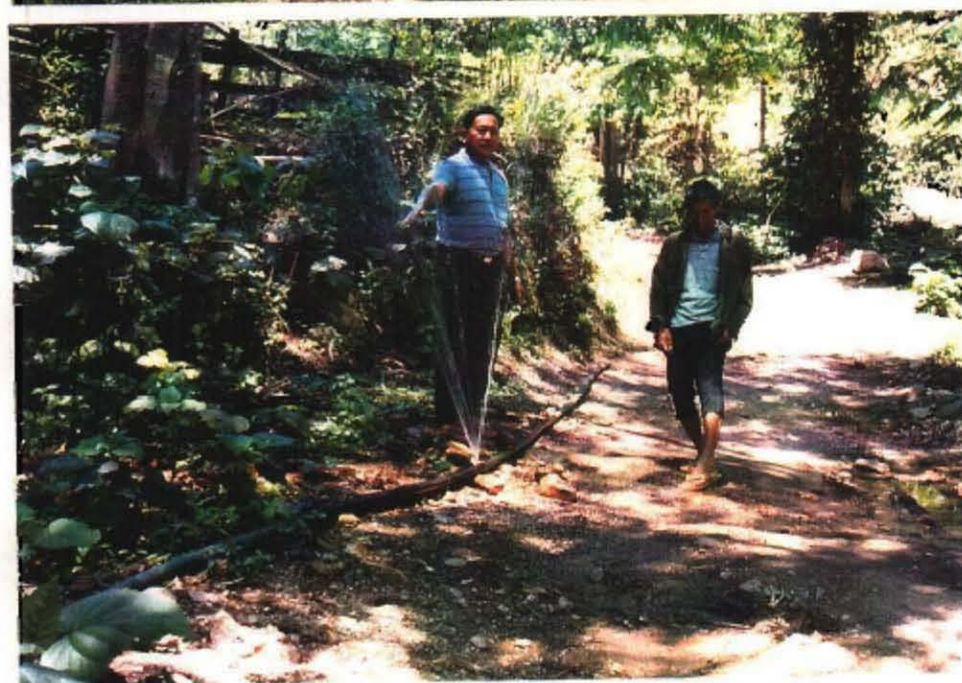
Shint Kaing 村のサトウキビ畑へ灌漑用水を供給するパイプライン。数箇所です水が漏れている。サトウキビはケシの代替作物として導入された。 (Hkar Ti Lin)
