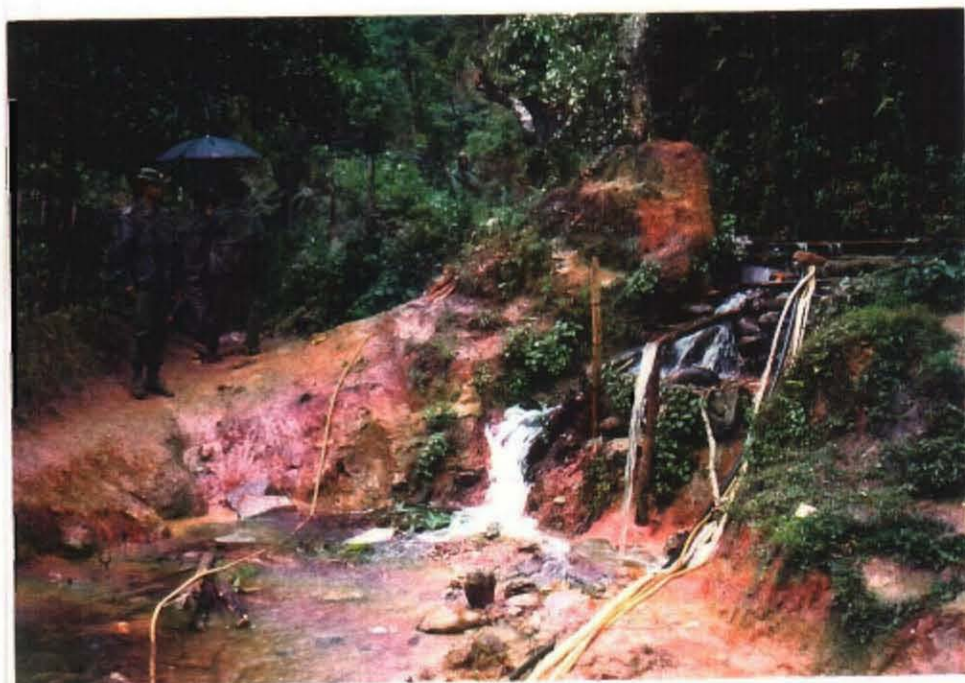
集落内を這う給水用のビニールパイプ。1.5km 程離れた河川より村落内に水路をひき、水路から各戸に直接パイプを引いて生活用水を賄っている。 (Hshao Kai)
