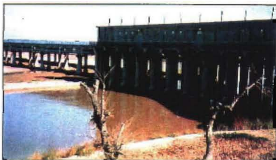
大凌河頭首工土砂吐工
