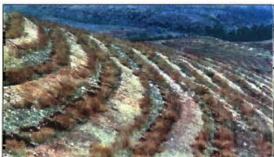
北票地区治山事業 (降水捕捉) 棚田工
