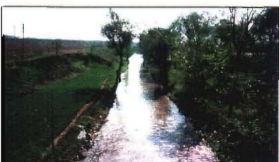
小凌河灌漑幹線水路
