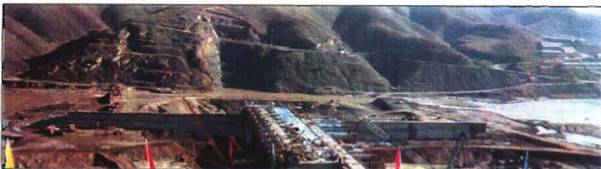
建設中の白石ダム
