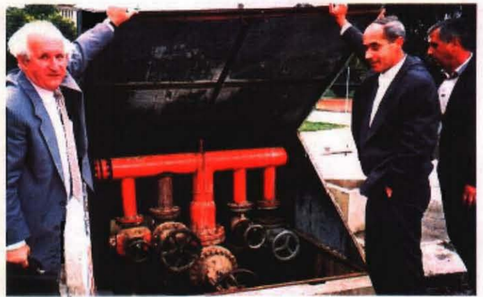
Vijeljina 市近郊 Dvorovi : 同温泉の水源制御装置
