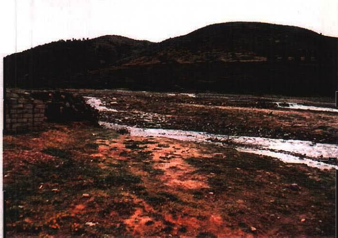
Marrakech 州 Tahanaoute 地区 : Asif Reraia 川に設けられた取水工
