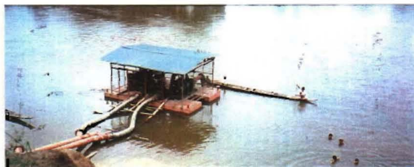
No.5 現在事業化進行中のセカマン川での小規模ポンプ灌漑（フローティングタイプ）
