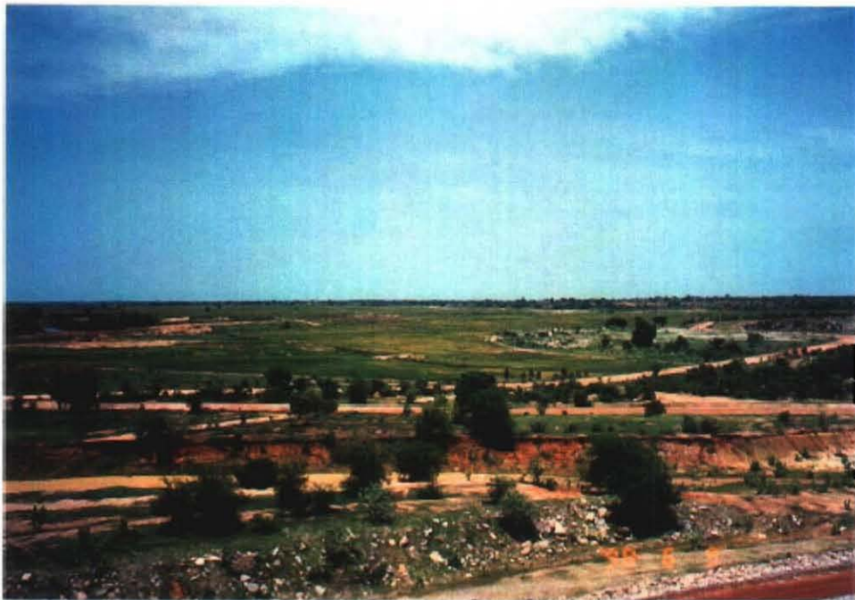
ダム堤頂部より右岸側 を望む
