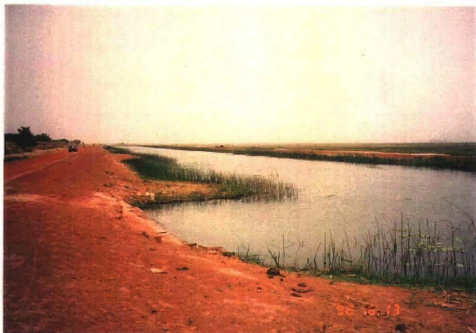
サヘル幹線用水路 (土水路)
