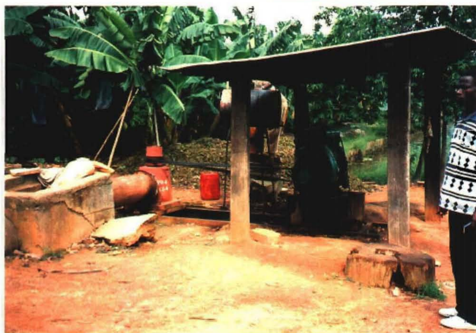
Nieky パナブ ランテーション内 の排水用ポンプ
