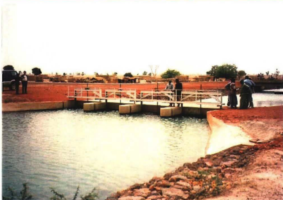
サヘル幹線用水路～ 二次用水路の分水工
