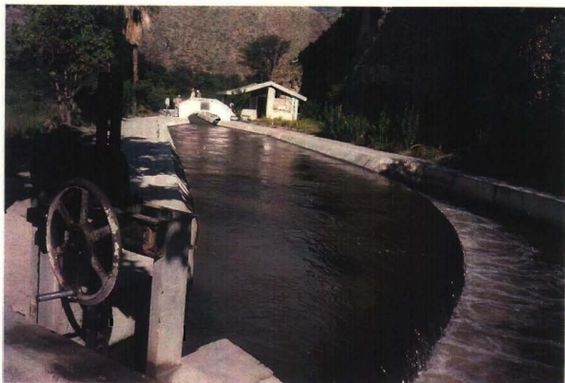
幹線水路に設けられた沈砂池の状況
