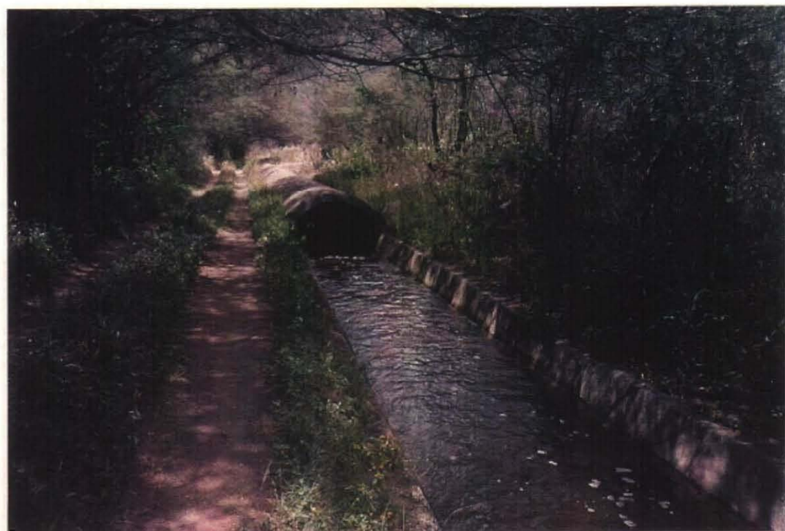
幹線水路(右岸側)と維持管理用測道
