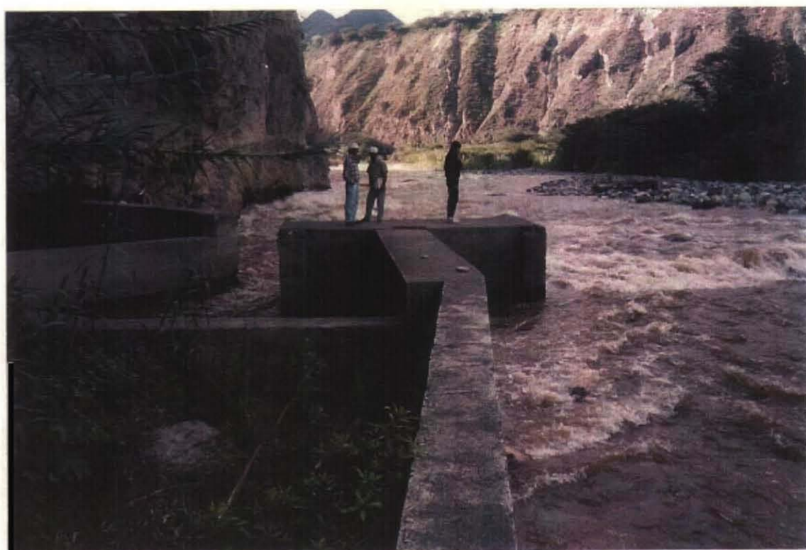
チョタ川に設置された取水堰の状況
