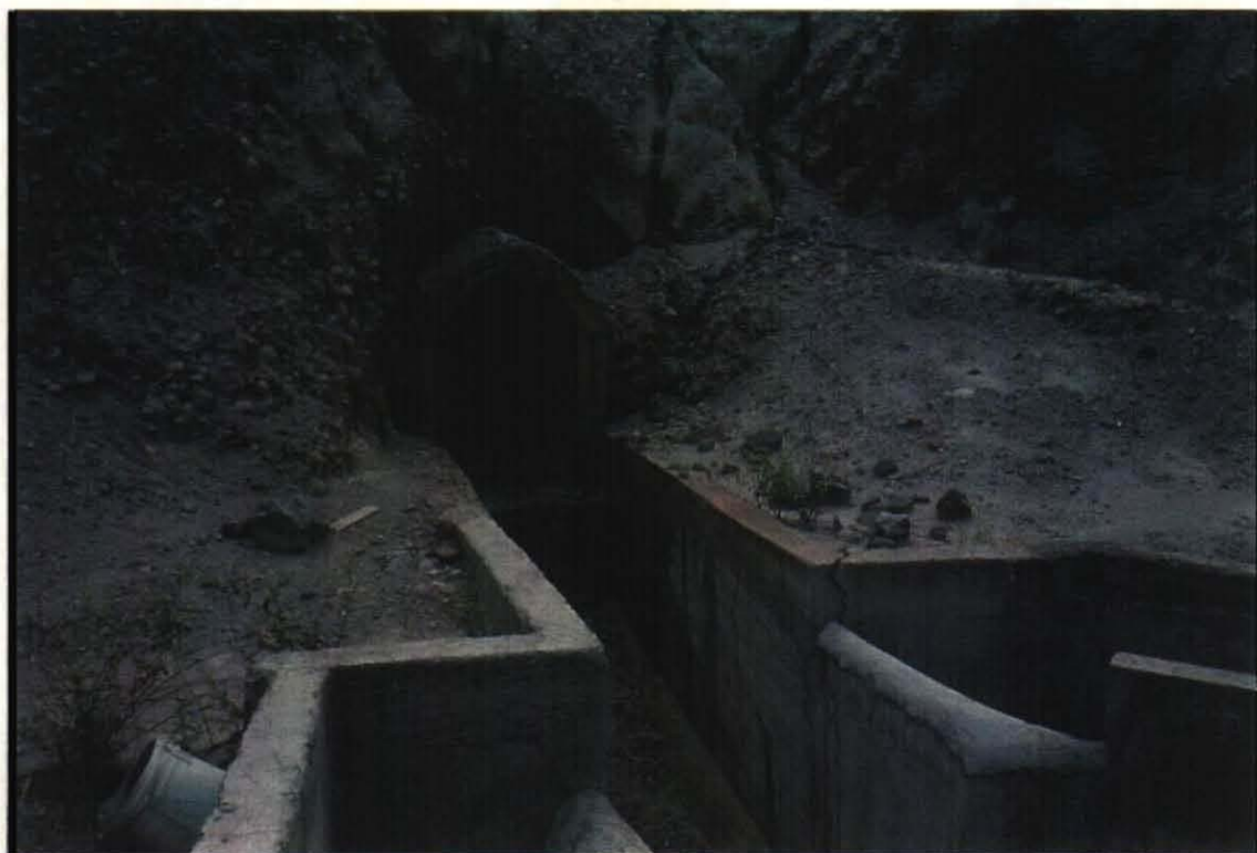
幹線水路(左岸側)トンネル坑口と分水樹
