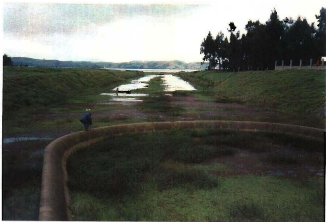
湖水位調整用の余水吐け堰堤と放水路
