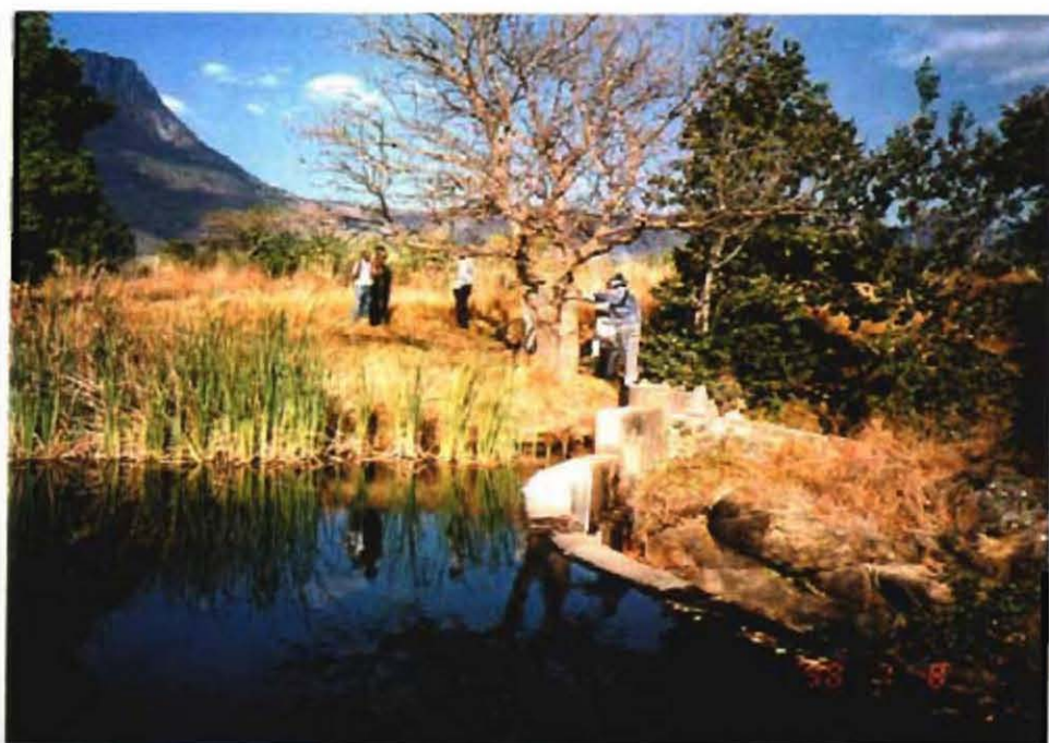
共同体地区小規模灌漑事業の取水堰と取水口 (1998年7月8日) (Mwenje Small-scale Irrigation Scheme)
