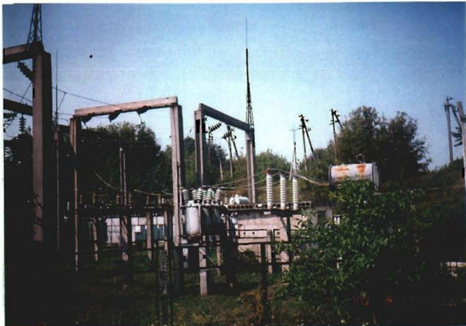
灌漑ポンプ場の変電所 全く機能していない
