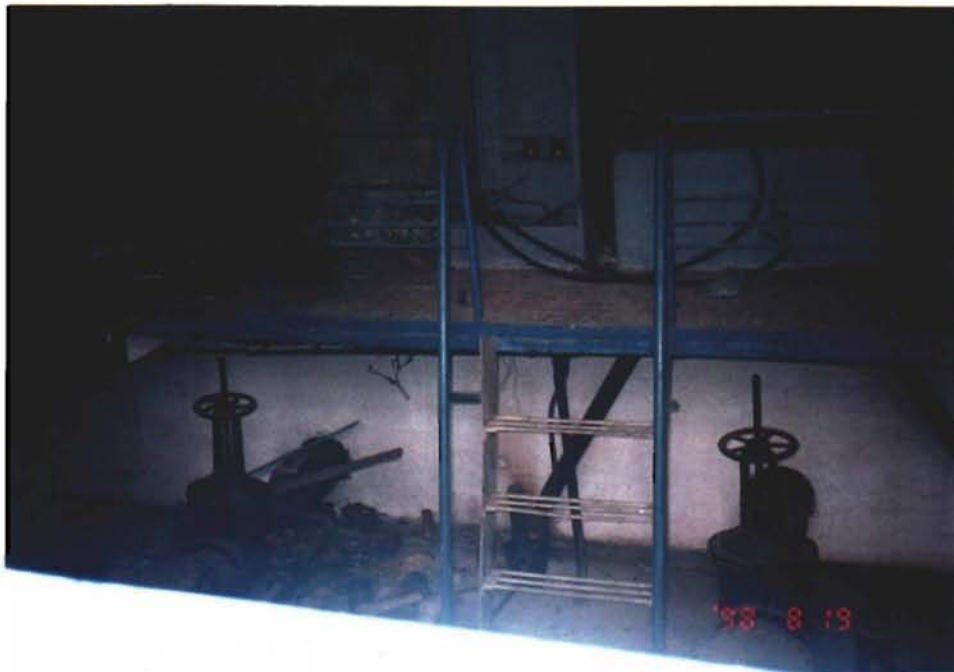
灌漑用ポンプ場の内部 全く機能していない
