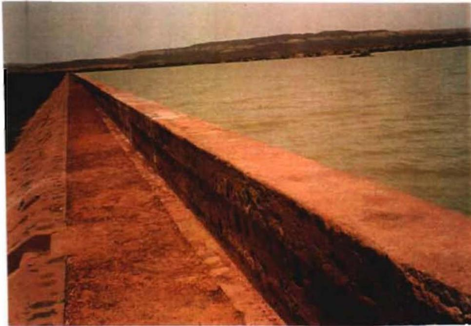
堤体頂部：コンクリートで嵩上げし水量確保を試みた
