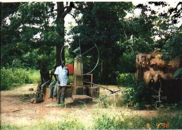
既存施設の現状(例、Ounhigouya) 浅井戸には水はあるが、ポンプが故障中、 事務所、倉庫建物はドア、屋根が壊れ使用出来ない。
