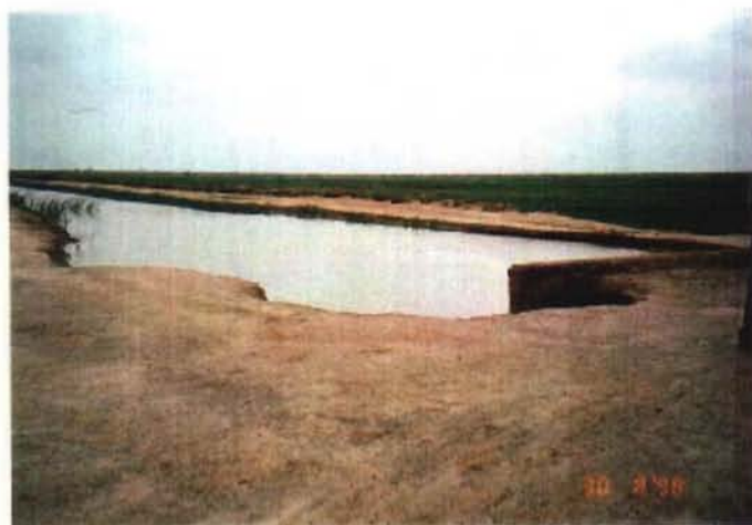
施設取付部の侵蝕状況
