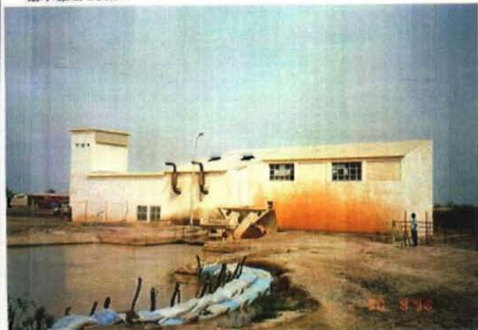
揚水機場と既設ポンプ
