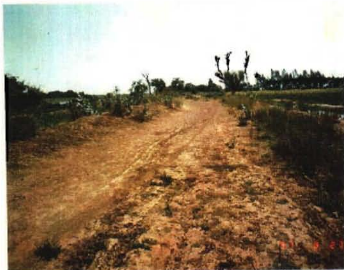
地区内の既存道路状況。現場の土を盛上げた道路であるため、排水が悪く、乾期でも左写真の通りである
