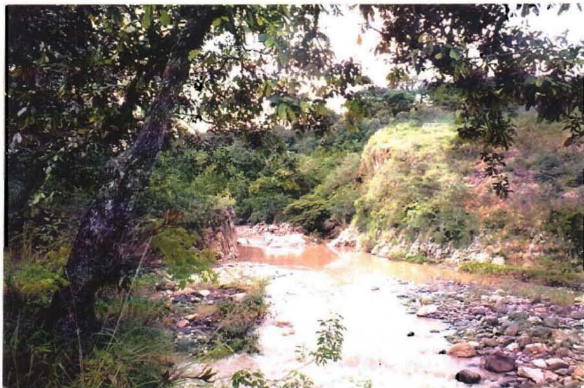
サン・ペドロ・ピヌラ地区ハラバ川取水工建設予定地（上流側）
