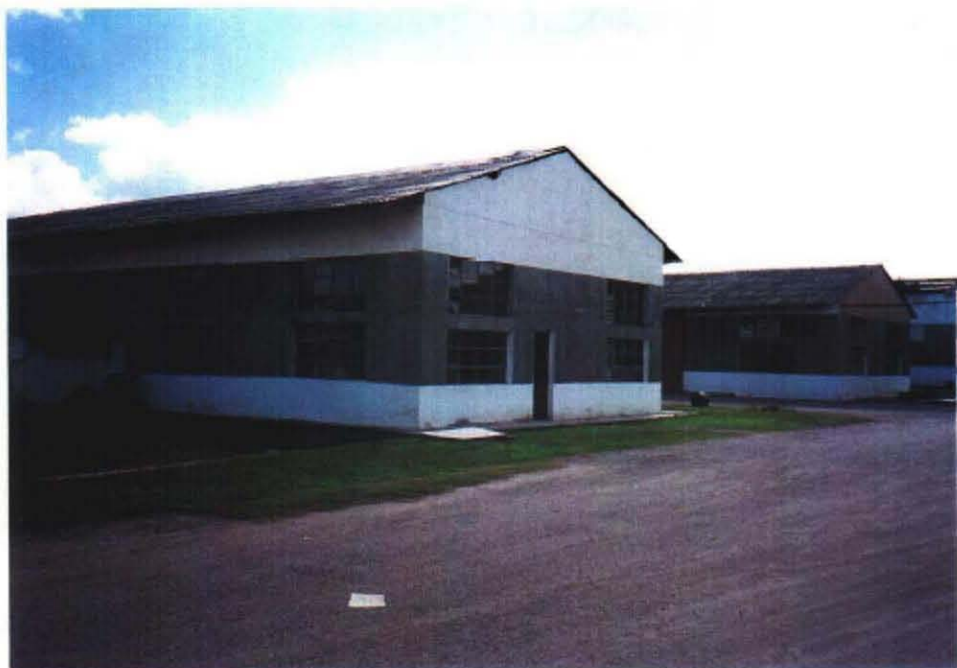
灌漑排水局の建物
