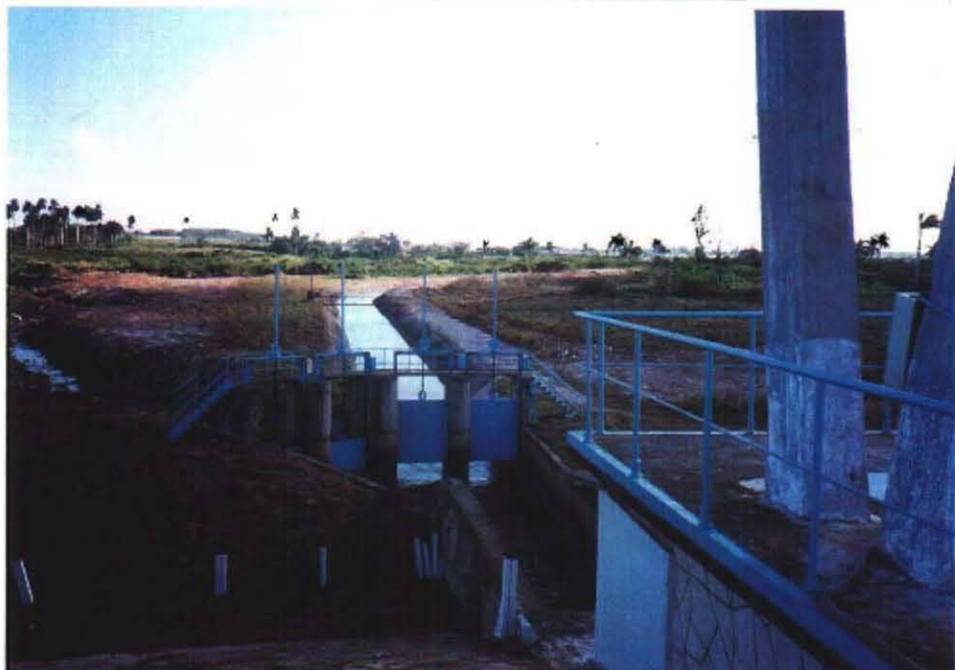
灌漑水路、分水工
