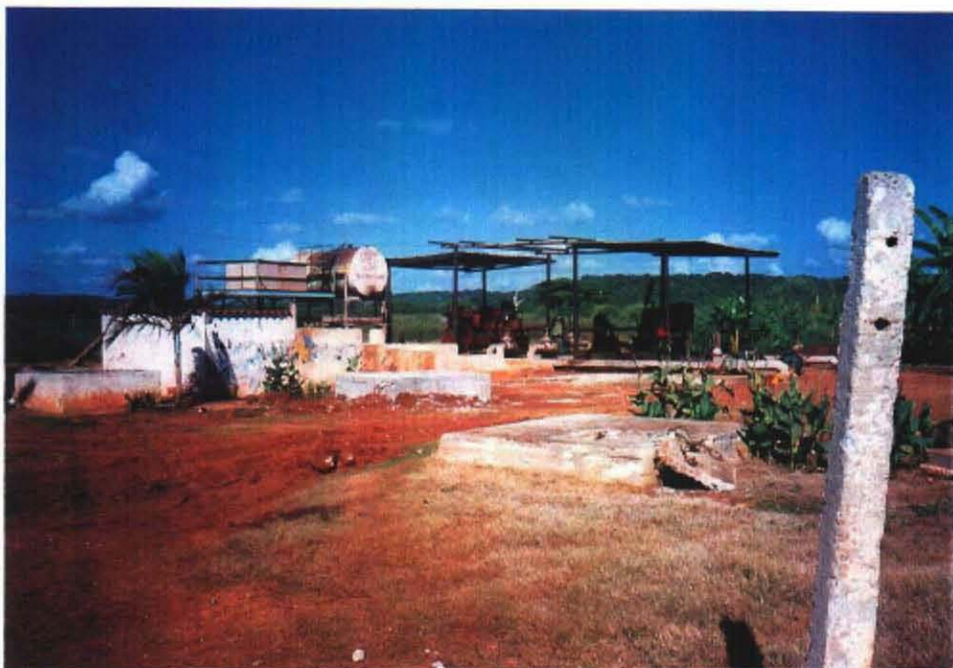
灌漑用ポンプ場
