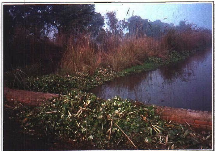
No.15 支線水路の水草 小規模の橋梁部にホテイアオイが密生しており、洪水の原因となっている。
