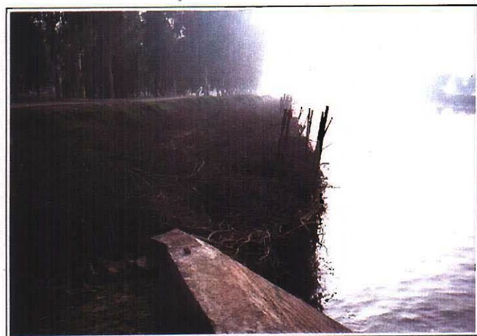
No.4 水路構造物の下流側の侵蝕された部分の保守状況 杭を打ち粗朶を置くことで侵蝕を防ぐとともに、土砂の堆積を進行させ、元の堤防の復旧を図る。
