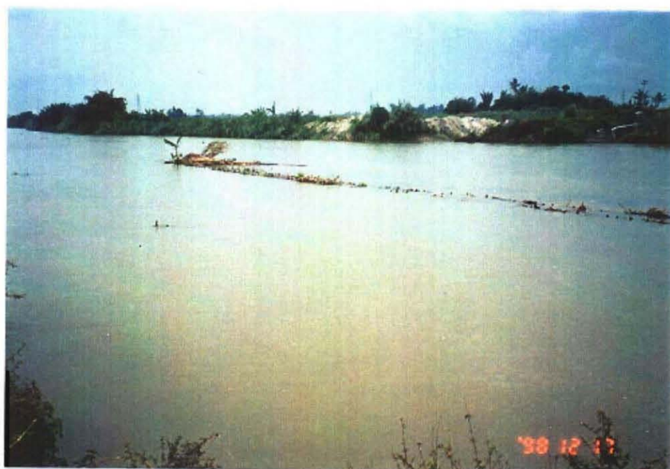
ベンダン取水工 (取水位低下対応のための簡易堰)
