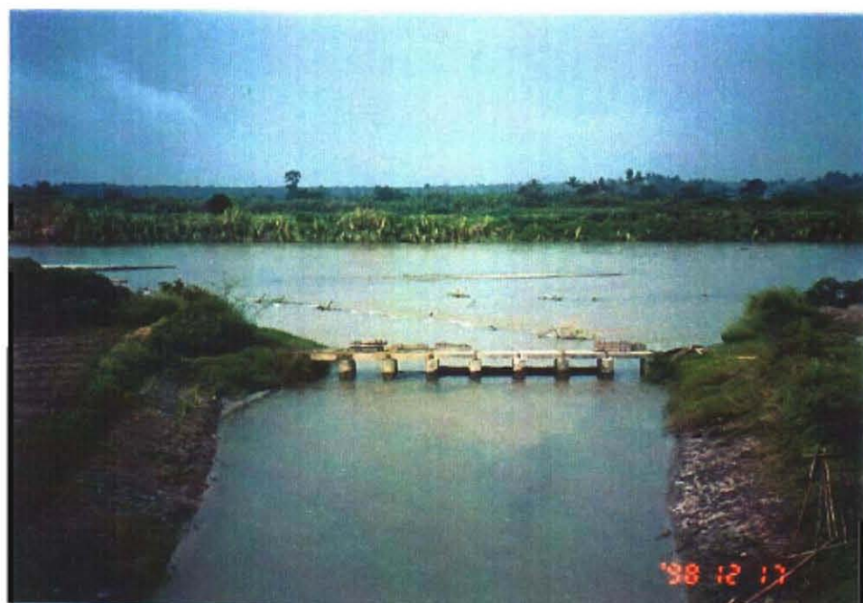
シンゴサリ取水工 (取水位低下対応のための簡易堰)
