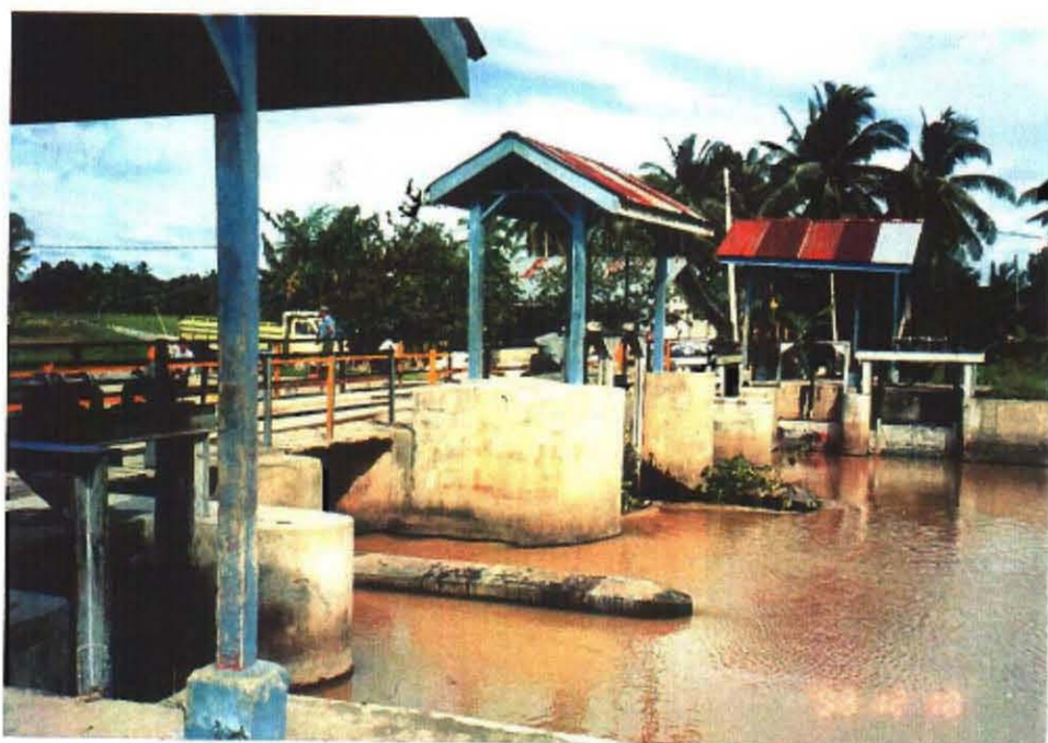
既存頭首工 (ブヌット川灌漑地区)
