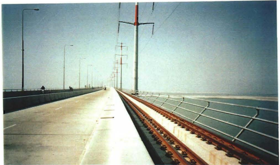
多目的橋梁の状況
