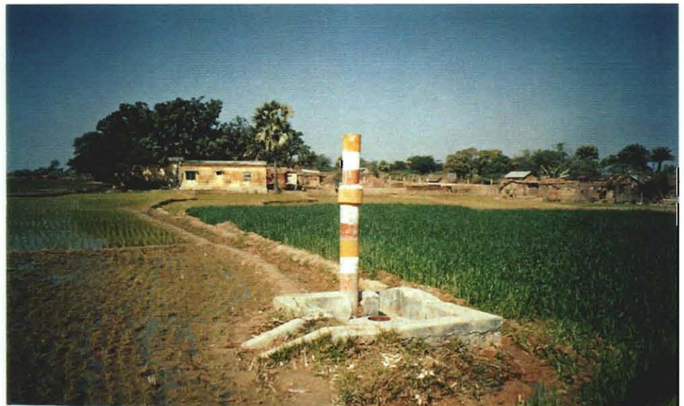
バルブによる配水 地点
