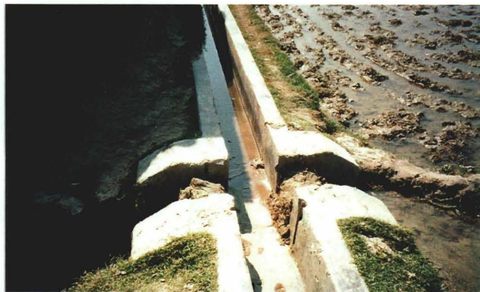
灌漑施設の分水工
