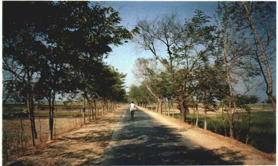
改修されたフィーダー道路 及び両側の植生
