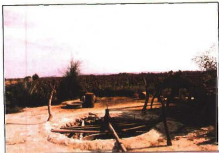
No.25 ポンプ バナナプランテーションのポンプ (地下水によるかんがい)
