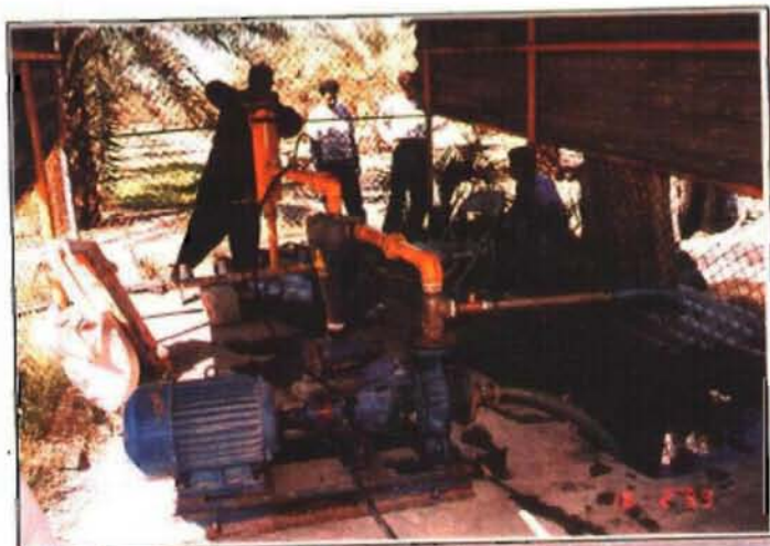
No.11 様々なかんがいシステムに送水する加圧ポンプ 開水路から吸水し加圧
