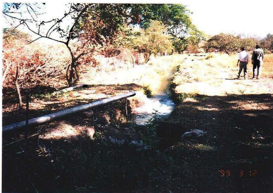
POLO 組織による小規模灌漑(河川ポンプ)の揚水状況
