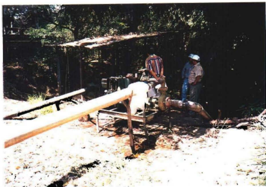
CIT 内既存の灌漑水源ポンプ
