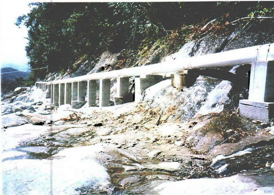
ハリケーン後に修 復された導水路
