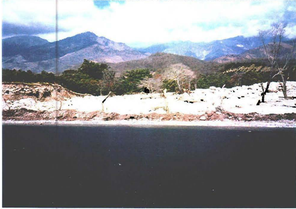
その後の復旧事業により、道路（手前）は修復されたが、河川は荒れたままになっている。
