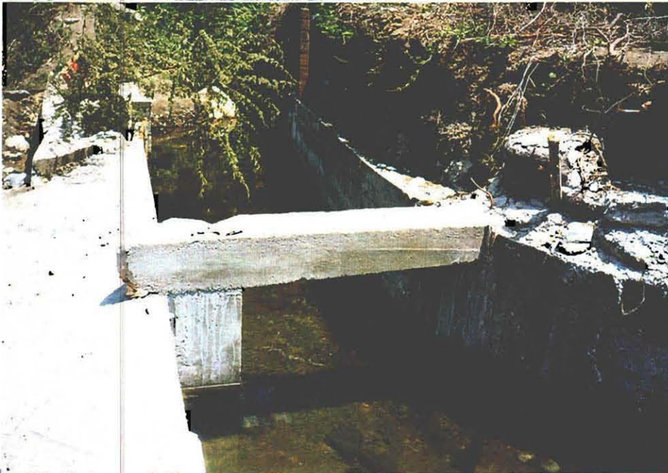
ハリケーン後に修 復された取水口
