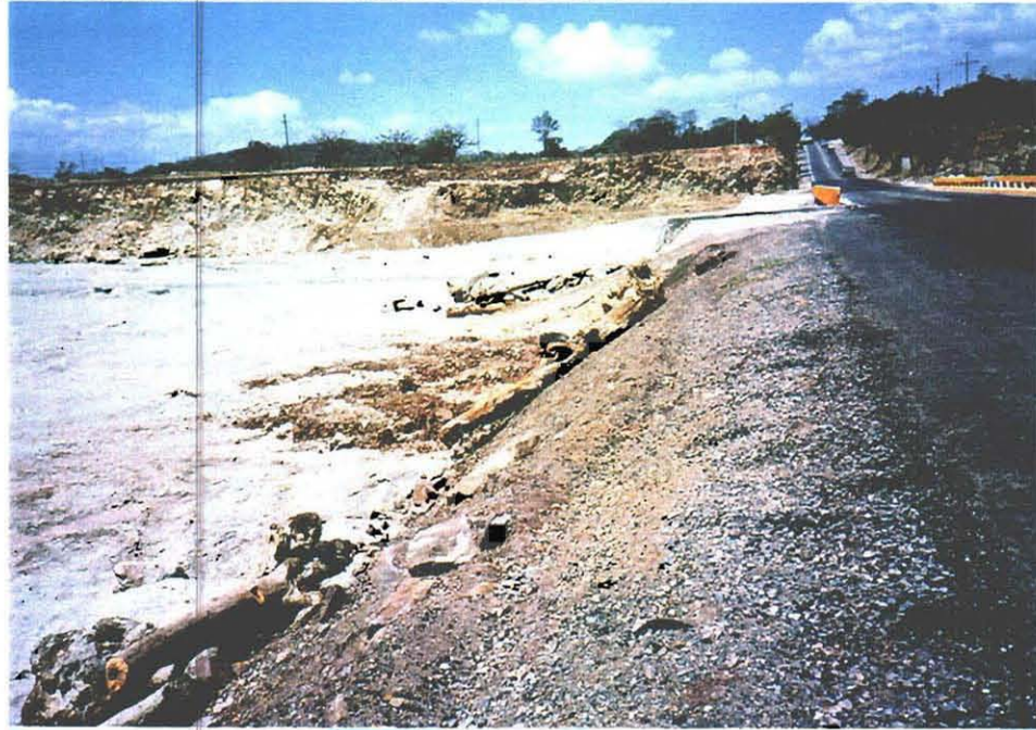
ハリケーンの襲来時にはこの道路も完全に冠水し、橋も破壊されたという。
