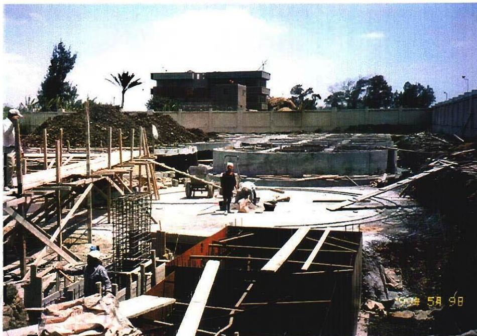
Behira 県 Damanhur。 フランスの無償援助により 建設されている穀物用サイロ (容量 10,000t、乾燥施設付)。 農業省が農協に経営を 移管する最初の事例。
