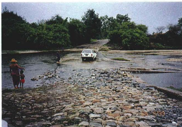
Mandalay 管区の北部にある Sedawagi ダムへ 31 号線から地方道に入り途中の川の横断箇所。敷いた割石が不揃いで車両の通行が困難 (1769-14)
