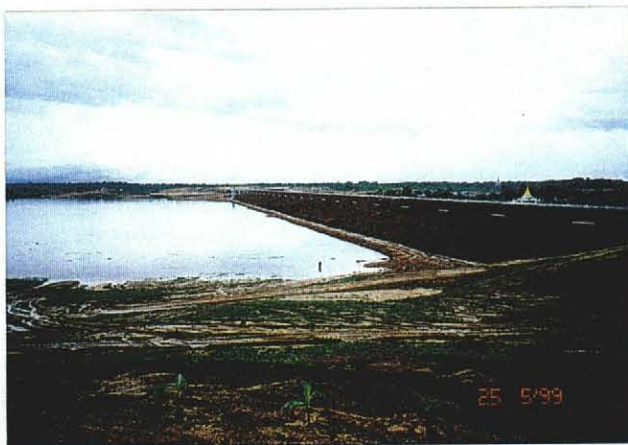
Bago 管区の Mazin Y-Sa ダム。灌漑(263ha)・上水道 ・洪水調整用。1999 年 6 月竣工(1328-25)
