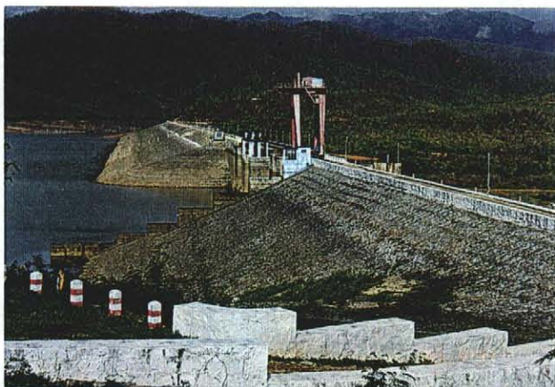
Mandalay 管区の Sedawgyi ロックフィルダム。灌漑(51000ha) ・発電(12.5MW)・上水道用。1976 年着工 1986 年完成 (1769-E)
