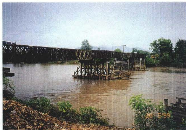
Mandalay 市から国道 31 号線を北上した Lamaing 町手前で見た組立式橋梁。(1771-5)
