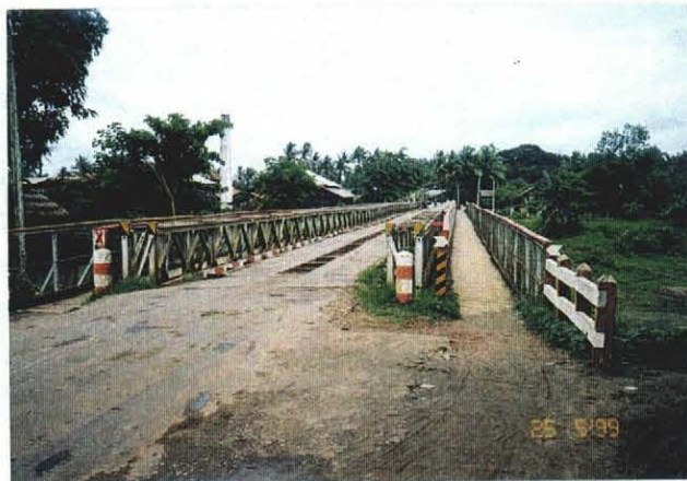
Bago 管区 Bago 市への途中、国道 1 号線の組立式橋梁。このタイプが一般的の様子。(1328-15)
