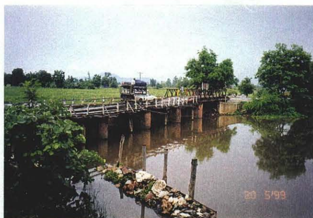
Mandalay 管区の北部地域で国道 31 号線の仮設橋。手前側は木材で仮設している。(1771-7)
