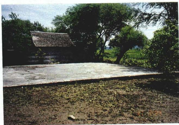
同じく普及事務所敷地内のブロックとモルタル製の粉等の乾燥場。(1771-20)
