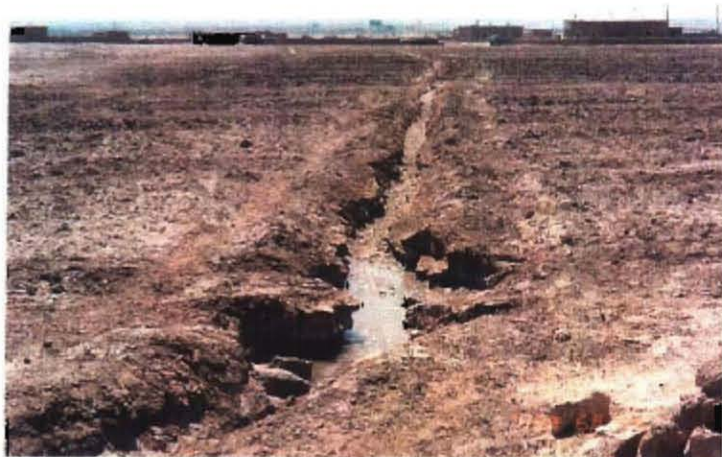
素堀水路による導水路 (Dier-ez-Zor)
