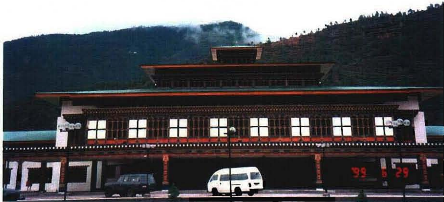
ブータン国 新装なったパロ空港メインビル
