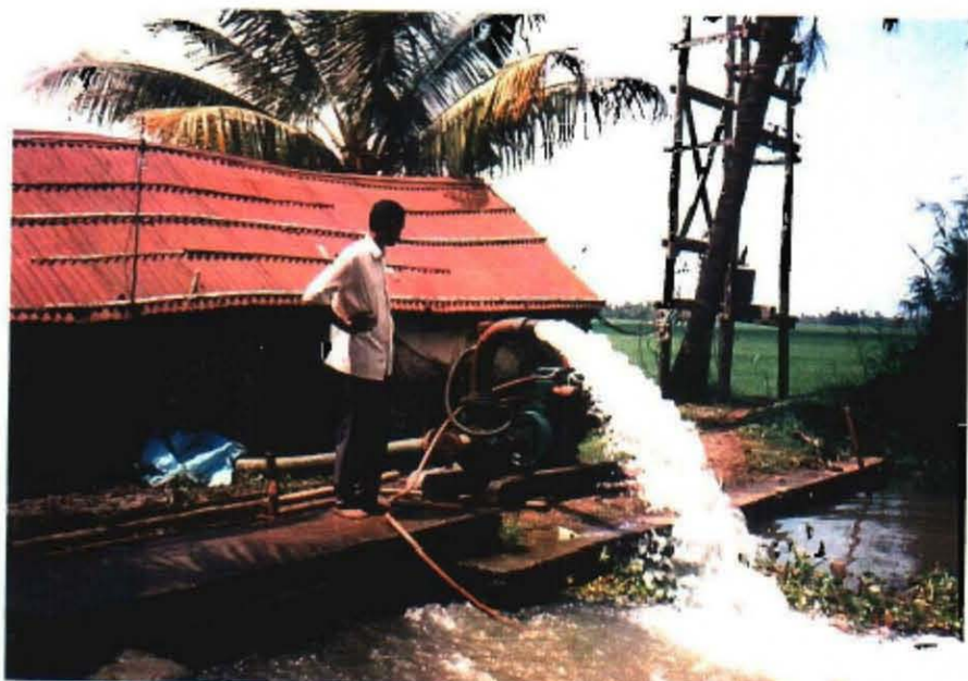
ケララ州中部水田地帯 ポンプで揚水している
