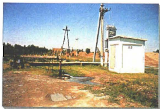
地下水排除用ポンプ
