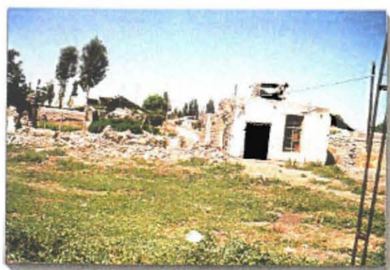
地下水上昇により倒壊した住宅
