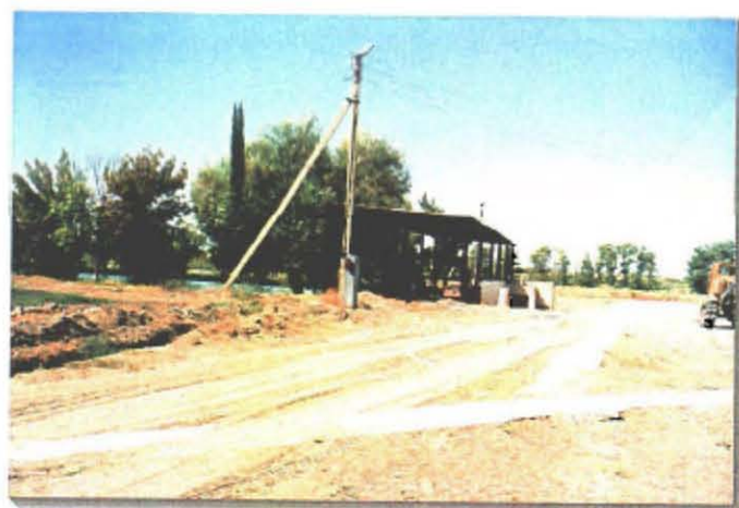
農場内灌漑用ポンプ場
