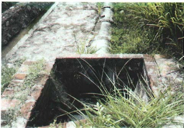
灌漑施設 (水路、分土工)
