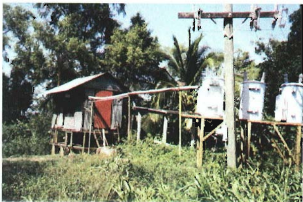
灌漑用ポンプ場設備
