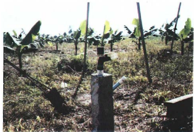
バナナプランテーションの散水灌漑施設
