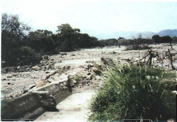
河川洪水により崩壊した取水セキ
