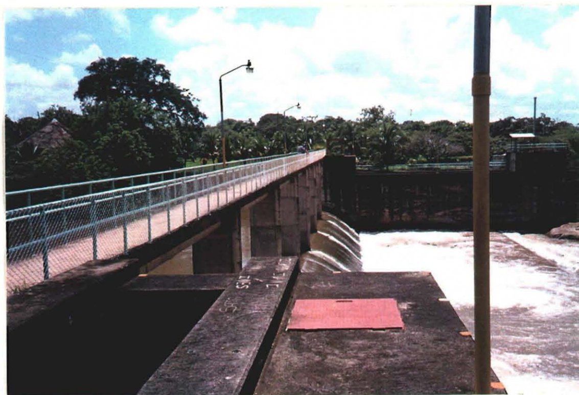
マグダレナ川に設置された取水堰の状況
