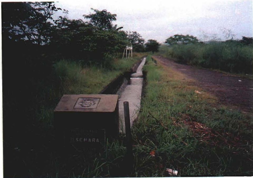
SENARAによってライニング整備された支線水路
