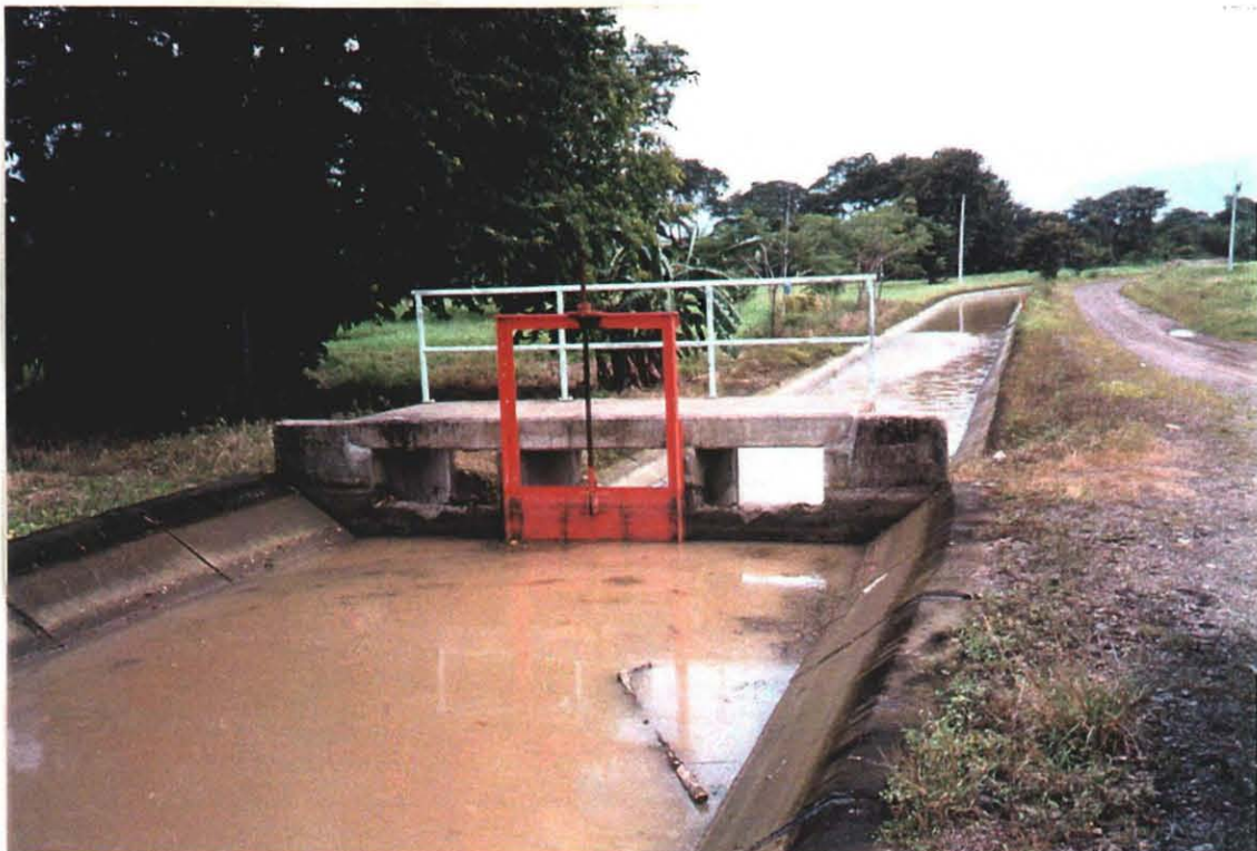
幹線より分水された支線用水路と維持管理用測道
