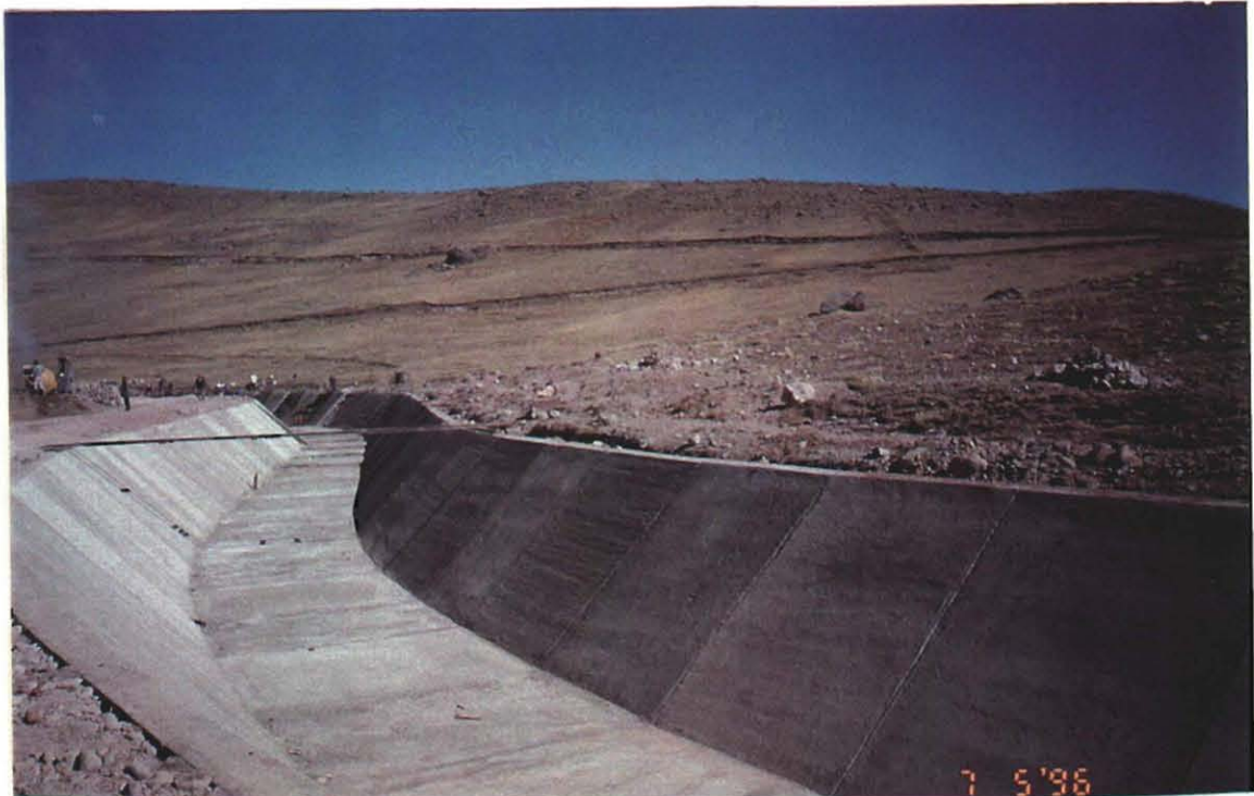
「タンボ・カラコッチャ計画」で完成したアンデス山地内の導水路
