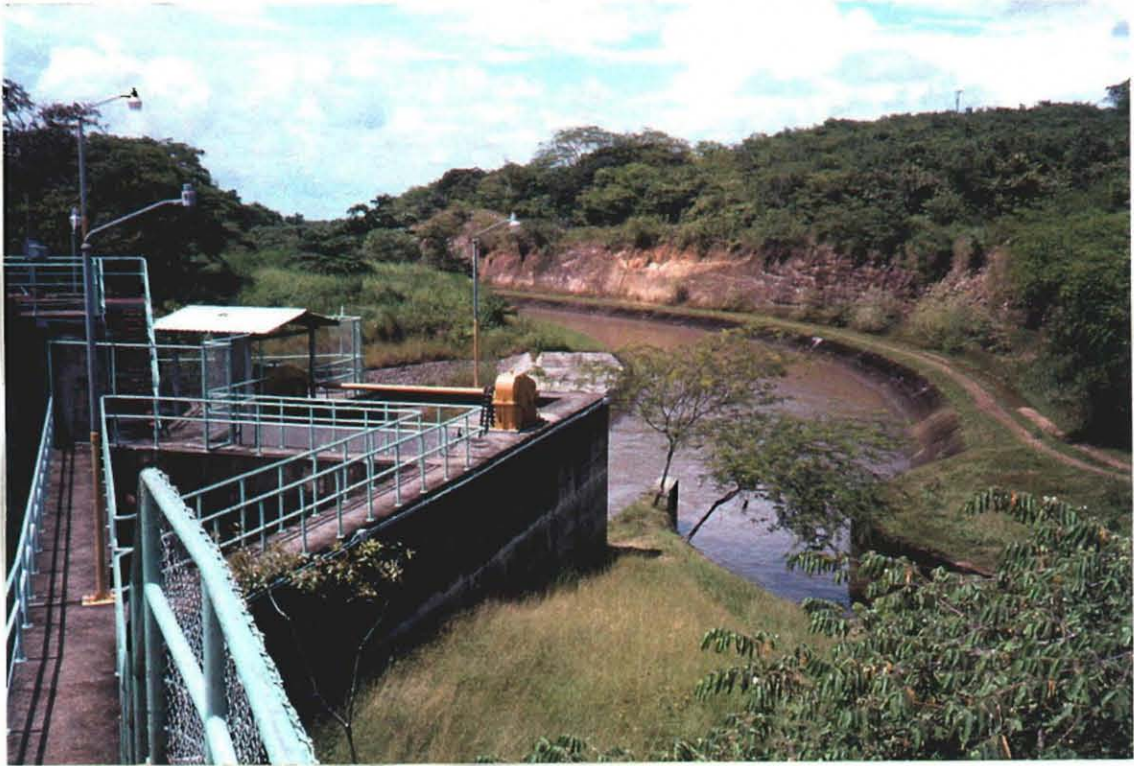
取水堰より取り入れられた西部幹線水路 ( Q_{\max}=55\text{m}^3/\text{s} ) の状況
