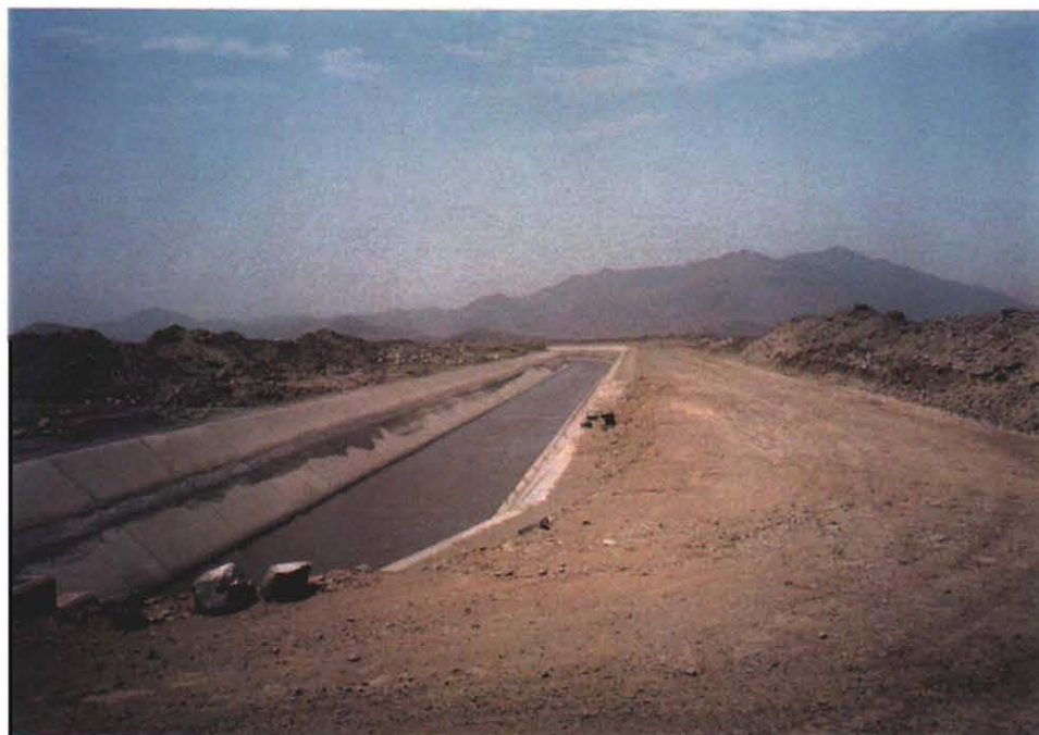
チネカス計画で建設された幹線水路
