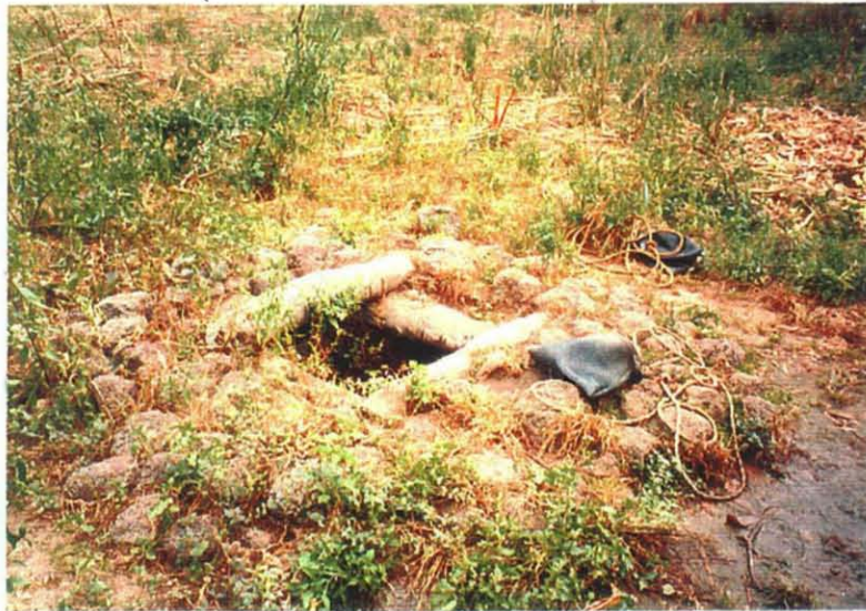
Sanankoroba 地区 生活用水用の浅井戸 タイヤのチューブ製の バケツで水汲みをしている
