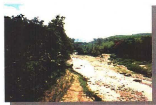
ソロ河支川上の灌漑用ダム計画地点 (上流方向を見る)
