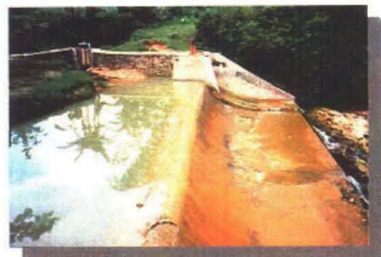
既存頭首工の破損水源
