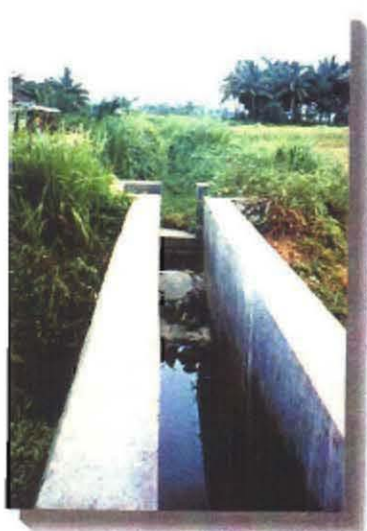
漏水のため 水のない 三次水路
