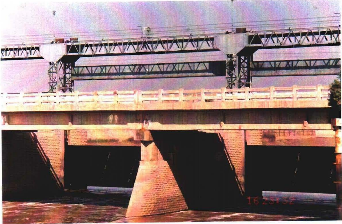
Punjnad 頭首工の中央部
