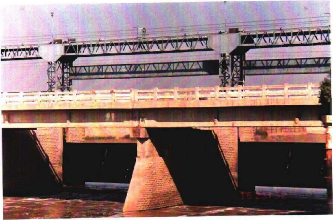
Punjnad 頭首工の中央部
