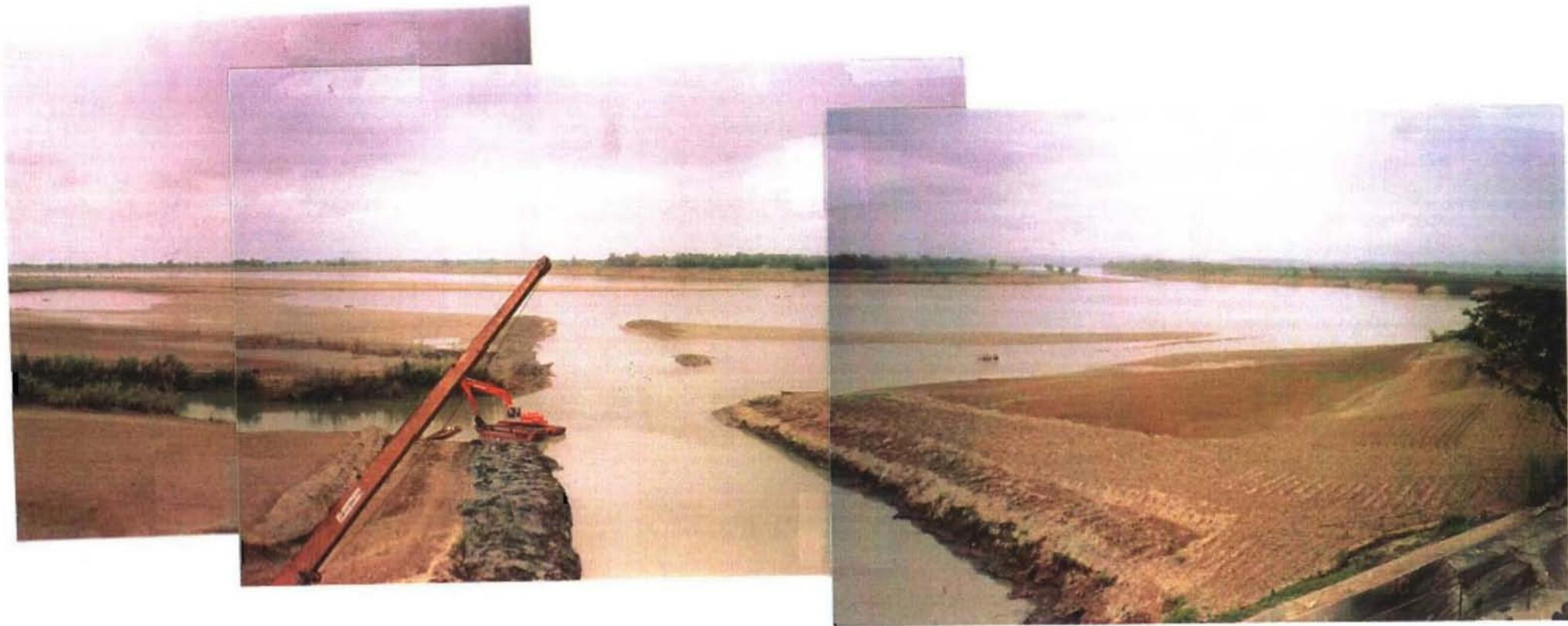
I A A P I S—アムルング機場 取水工前面の堆砂状況と取入水路。
