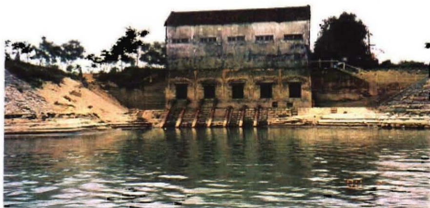
クアンナム省トゥボン川下流部のポンプ場。
