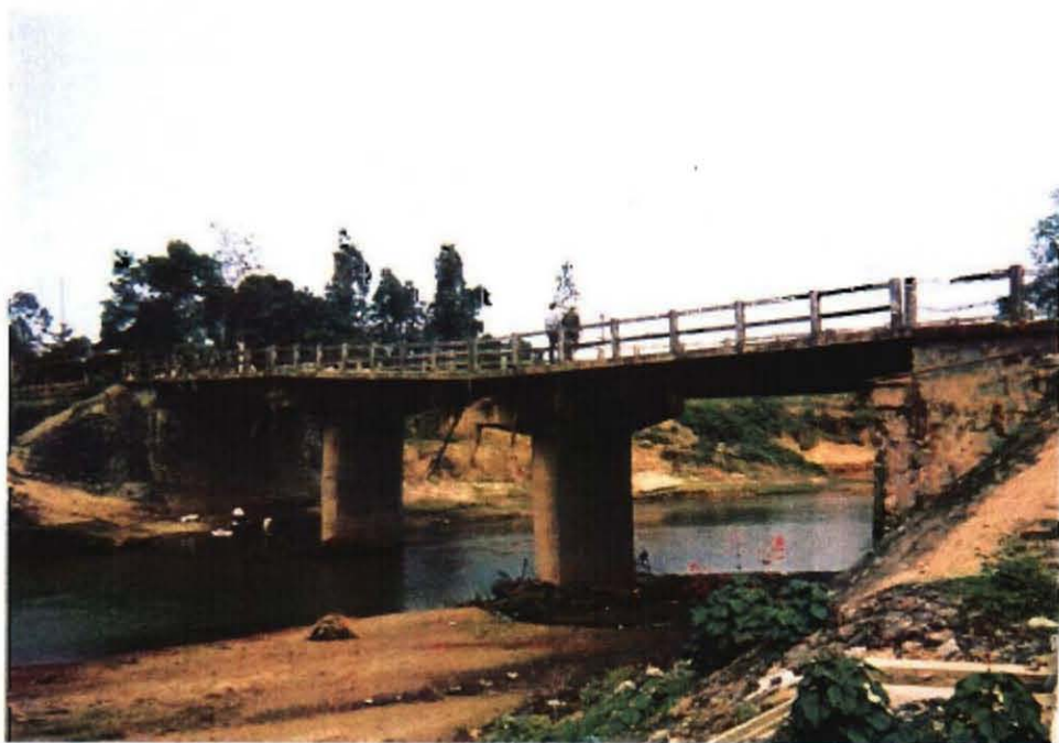
ダナン市郊外。グデ川上流部では流速が早かったためこうした被害も多い。
