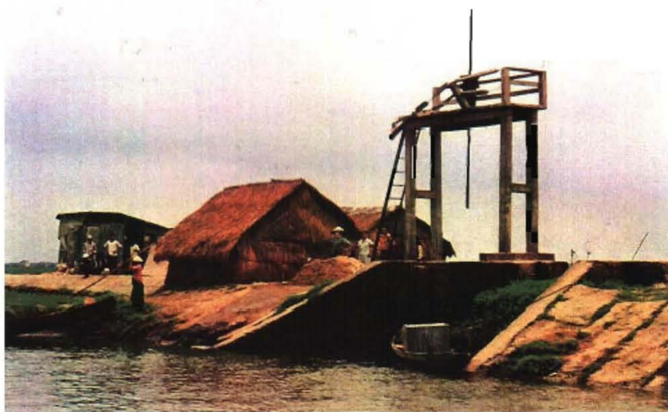
クアンチ省タツカン川下流部の既存用排水路の機門。
