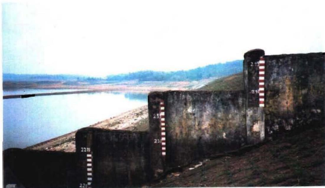
Dong Mo 貯水池、堤体に取り付けられた水位観測ゲージ、貯水池の水位は低い
