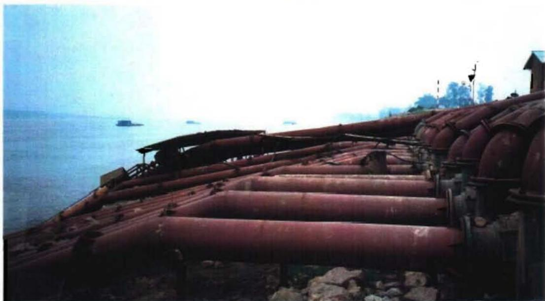
紅河からの直接取水しているポンプ揚水の取水パイプ、老朽化している。
