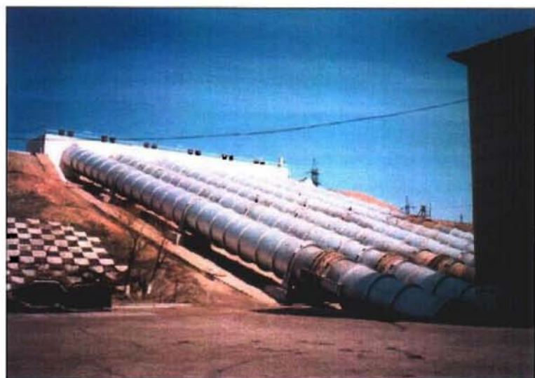
ブハラ州のアム・ブハラ運河 Kuyu Mazar ポンプステーション
