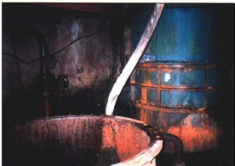
Kuyu Mazar ポンプステーションの軸流ポンプケーシング。分解修理中。 内部ローターの径は1,600mmである。
