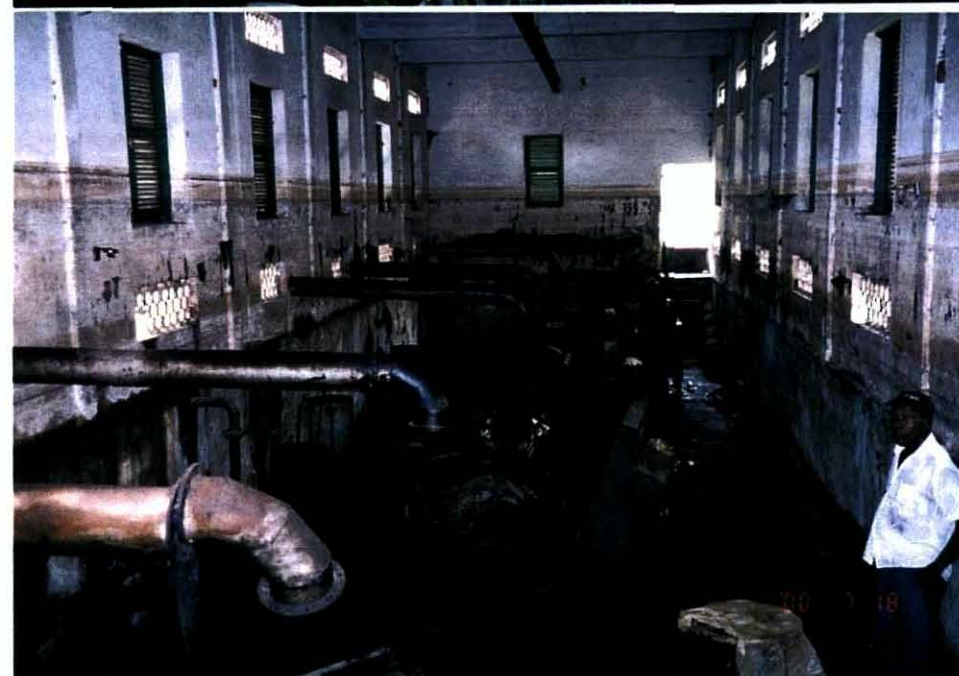
⑫ 1975年に完成したポンプ場 現在は機能していない。
