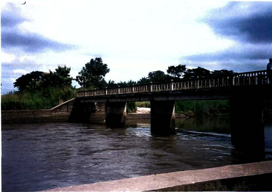
⑧ ズイオ川頭取工 現在の灌漑地域はこの頭取工から、灌漑用水を取水している。
