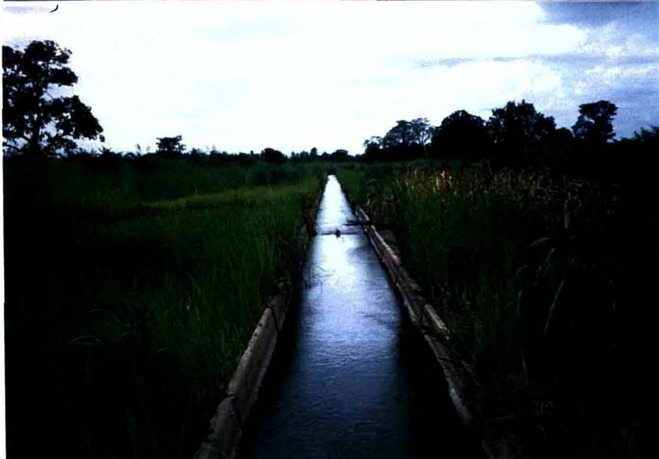
⑨ 幹線用水路 比較的よく管理されている。
