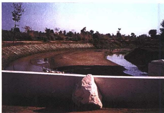
Lower Bari Dhab Canal の2次幹線水路の堆砂状況
