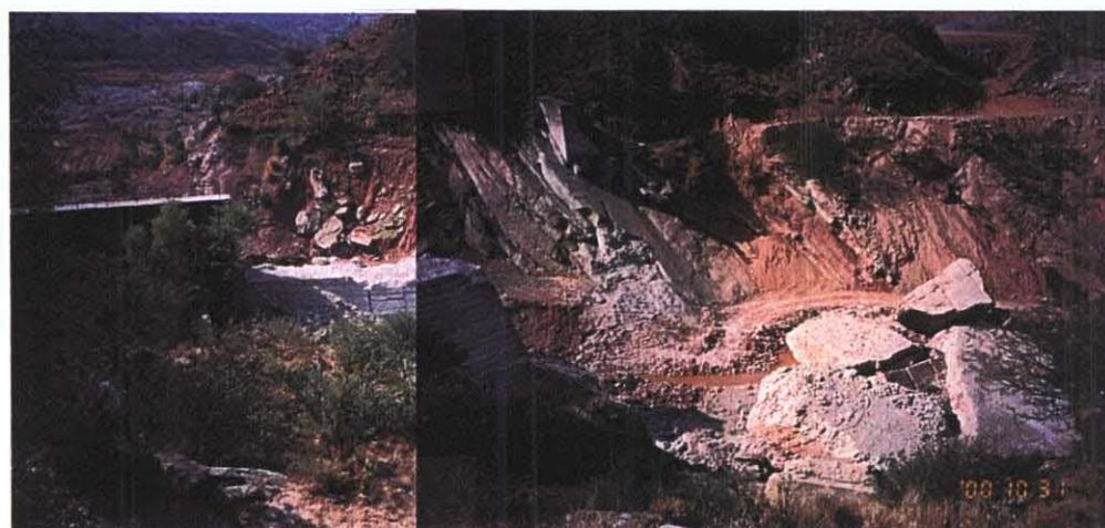
基盤滑動により倒壊した Dhok Tahlian Dam
