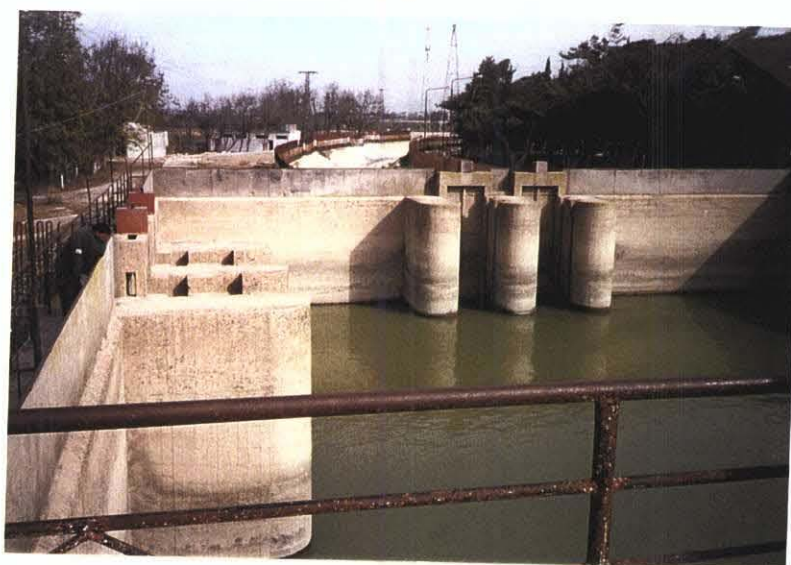
Qatceenah 湖の国営灌漑水路取水工 (Homs)
