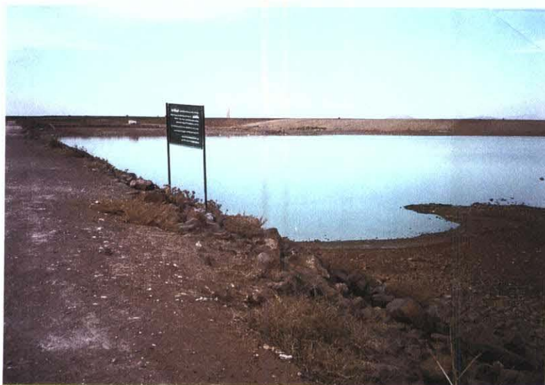
デッドウォーターのみとなったダム (Dara)
