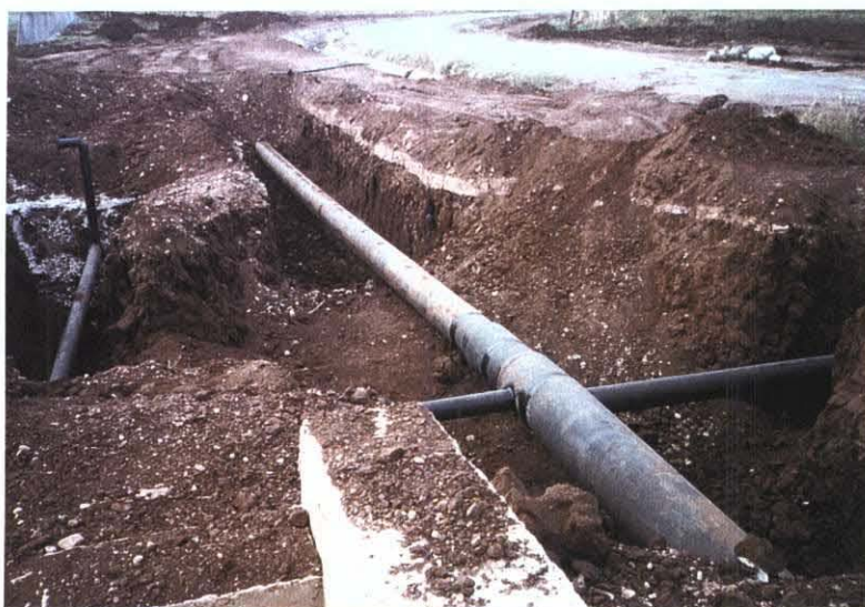
蒸発を防ぐため開水路を管路に変更 (Old Yormuk Project)
