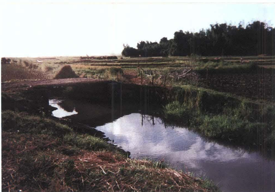
同上、老朽化した灌漑水路
