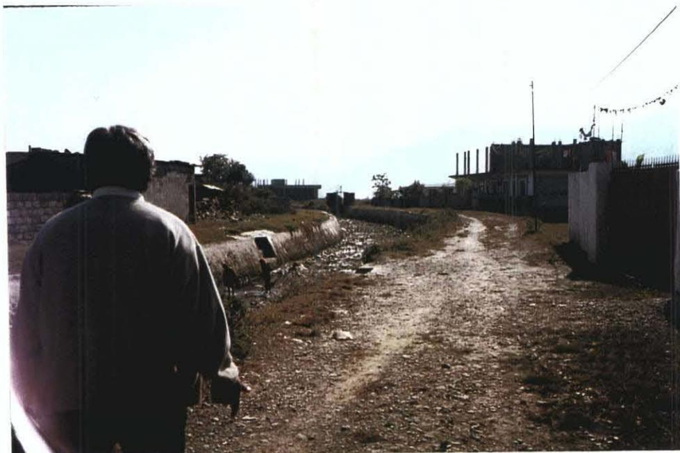
幹線水路の維持管理が不十分な為、水路底全面に土石が散乱している
