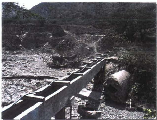
洪水により破損した水路橋の補修状況。 水利組合員による直接施工。
