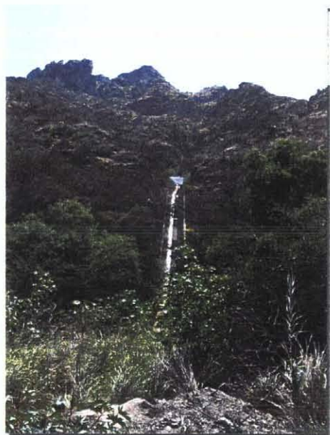
右岸地区へ配水するためのチョタ川横断サイフォン。
