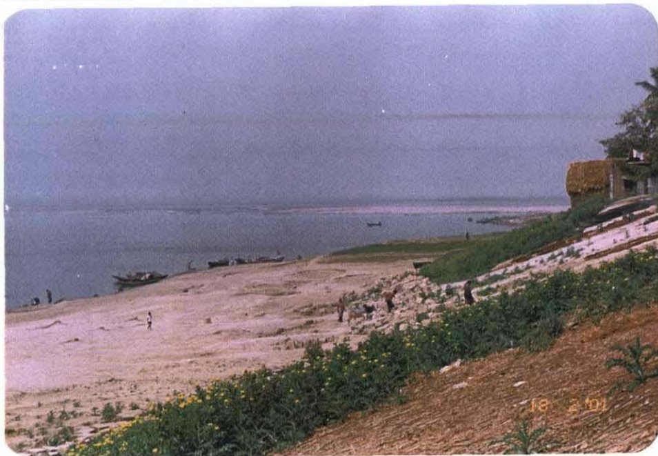
④ Baraipara ポンプステーション 付近の光景(1)。
