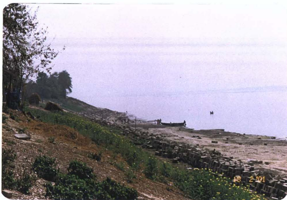
③ Baraipara ポンプステーション付近。防御堤の状態は安定している。
