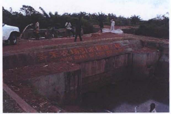
Doho 灌溉プロジェクト（国营）頭首工 上流側
