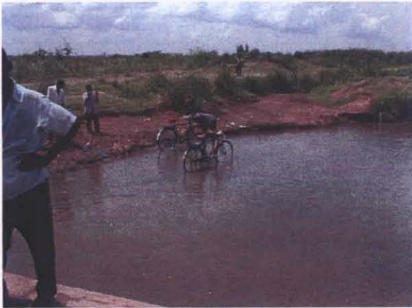
Doho 灌溉プロジェクト 幹線用水路 (滞砂と水路法面の崩壊が進んでいる)
