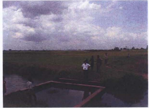
Doho 灌溉プロジェクト 分水工 (老朽化のため機能を失っている)
